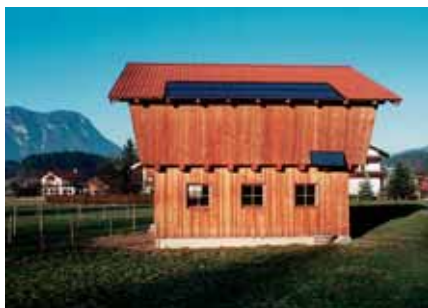
Anlage: DI Bartl, Jenbach
