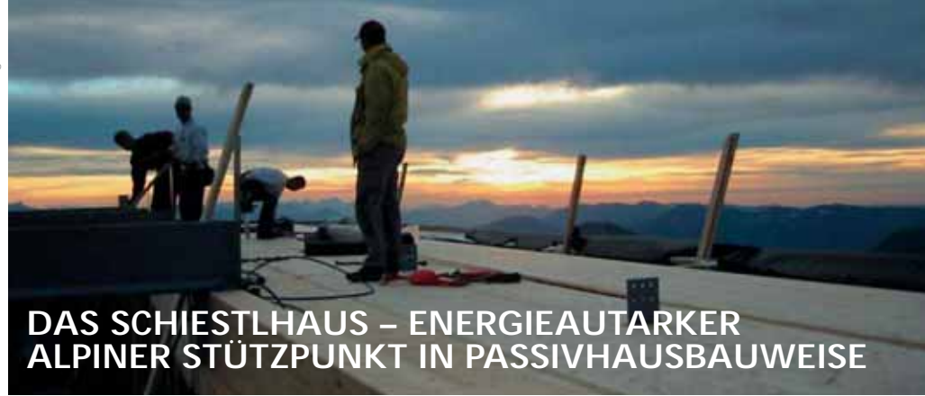
Foto: Geislinger Bau
