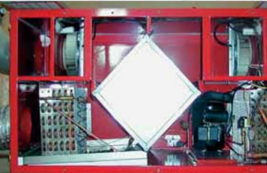
Lüftungsgerät mit Kreuzstrom-Wärmetauscher und integrierter Wärmepumpe.
