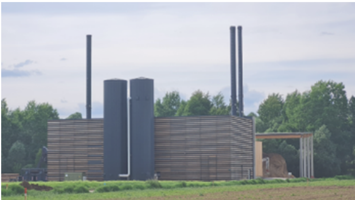
Abbildung 16 – Ansicht des 2023 in Betrieb gegangenen Heizwerks Wollsdorf in der Steiermark, inklusive der beiden jeweils 200 m 3 fassenden Großwärmespeicher Bildnachweis: © AEE INTEC
