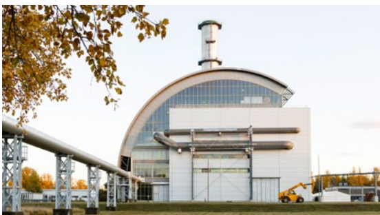
Donaustadt power plant, photo: Wien Energie/Max Krapitz
