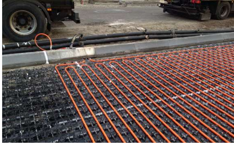
Asphaltkollektoren, Foto: Ooms Producten
