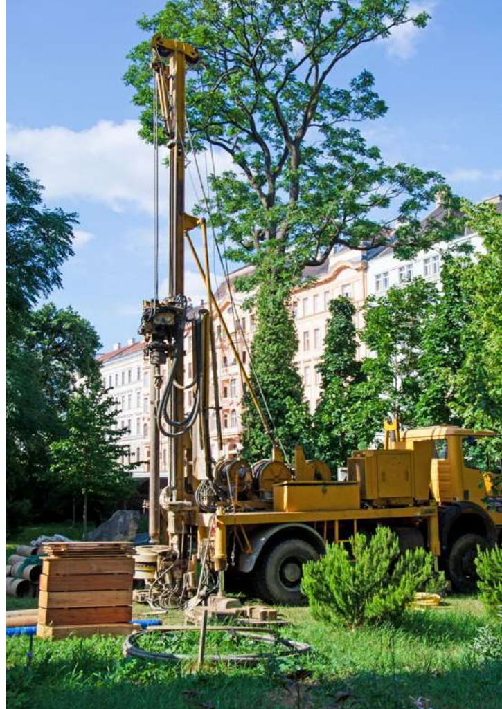
Bohrung der Test-Erdwärmesonde, Foto: Heat Harvest-Konsortium
