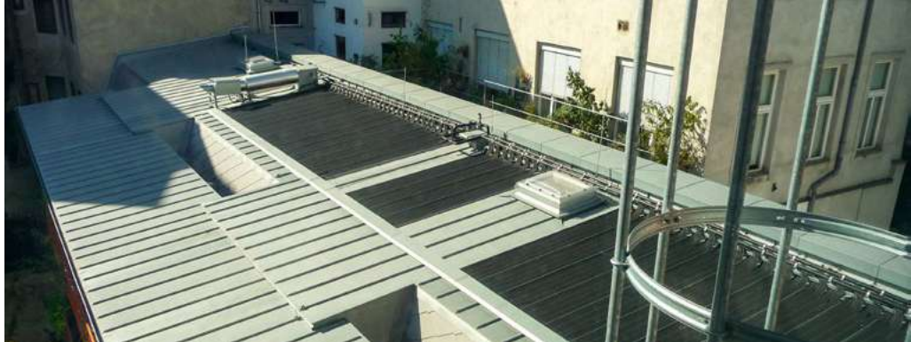
Absorbermatten, Smart Block Geblergasse, Foto: Katharina Zwiauer
