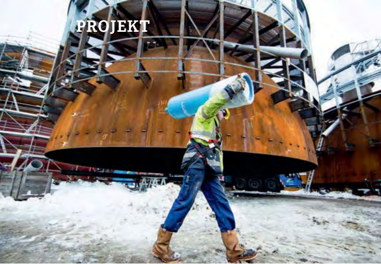
Bau des Hochdruck-Wärmespeichers, Quelle: Wien Energie/Ian Ehm
