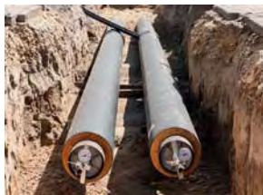
Fernwärmeleitungen, Quelle: fefufoto, fotolia.de
