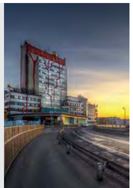
Fernwärme Wien Spittelau, Quelle: reinhardkiss, foto12.de
