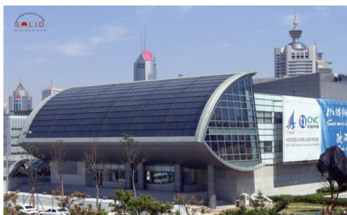
Abbildung 36: Lieferung und Montage von 1.300 m 2 Kollektorfläche zur Beheizung des Sport- und Trainingszentrums für das olympische Dorf in Qintao (China) durch das Grazer Unternehmen S.O.L.I.D.
