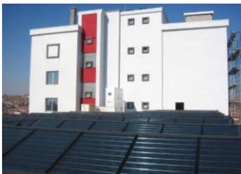
Abbildung 42: Solares Kühlen beim EAR-Tower in Prizstina, errichtet durch das steirische Unternehmen S.O.L.I.D.
