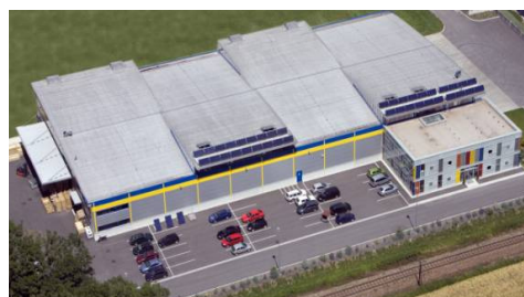
Abbildung 26: Der oberösterreichische Kollektorproduzent und Systemanbieter GASOKOL ist 2007 in das neu errichtete Betriebsgebäude in Saxen eingezogen und beschäftigt gemeinsam mit dem Zweitsitz in Grein über 80 MitarbeiterInnen.
