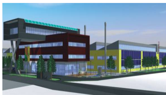
Abbildung 28: Der Kollektorproduzent Sun Master Energiesysteme zieht im Herbst 2008 mit seinen knapp 100 MitarbeiterInnen in die neue Produktionsstätte in Eberstalzell, OÖ, ein. Die mögliche jährliche Produktionskapazität beträgt bis zu 1,5 Mio. m 2 Kollektorfläche.
