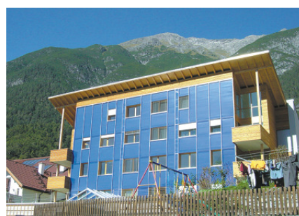
Abbildung 45: Farbige Absorberschichten als gestalterisches Element der Architektur (TISUN, Tirol)
