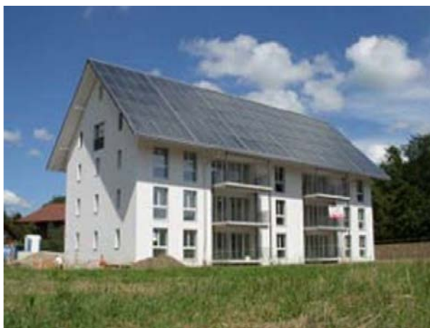
Abbildung 16: 100% solar beheiztes Mehrfamilienhaus in der Schweiz mit 193 kW th installierter Leistung und 205 m 3 Wärmespeicher
