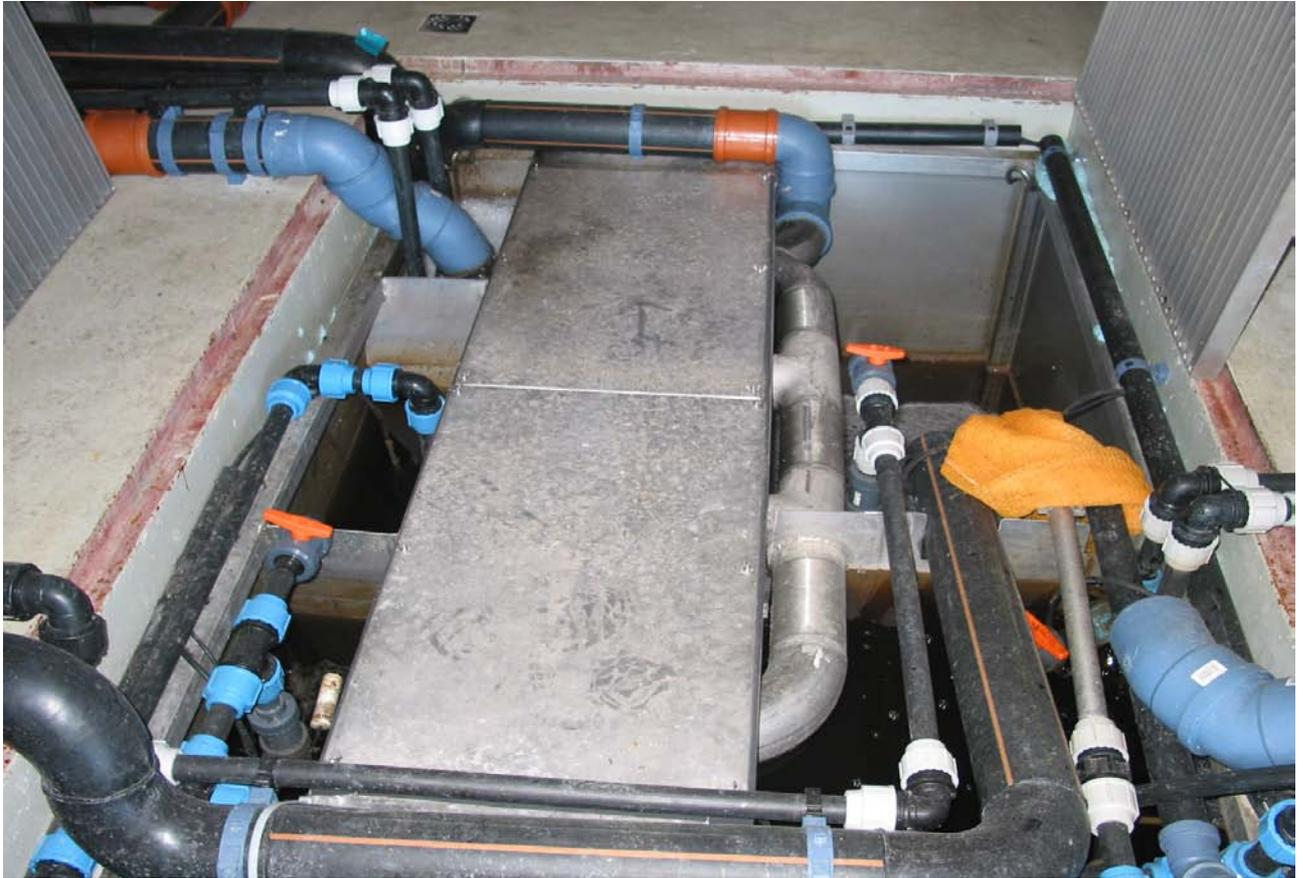
Abbildung: Bodenschacht mit Absetz-/Pufferbecken, Vorlage und Nachklärbecken sowie Filtersäcke
