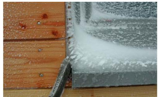
Besondere Bedeutung kommt der dichten Ausführung des Fenstereinbaus zu. Die Fensterrahmen wurden innen und außen mit speziellen Klebebändern an die Leibungen angeschlossen. Im Außenbereich wurden bei Leibungsbrettern und Sohlbänken zusätzliche Dichtbänder einsetzt.
