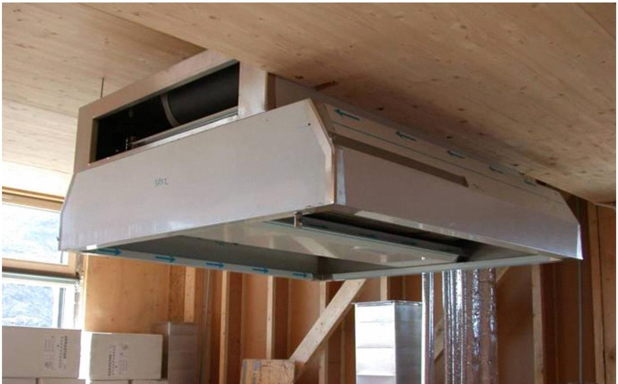
Abb.: Dunstabzugshaube mit Wärmerückgewinnung
