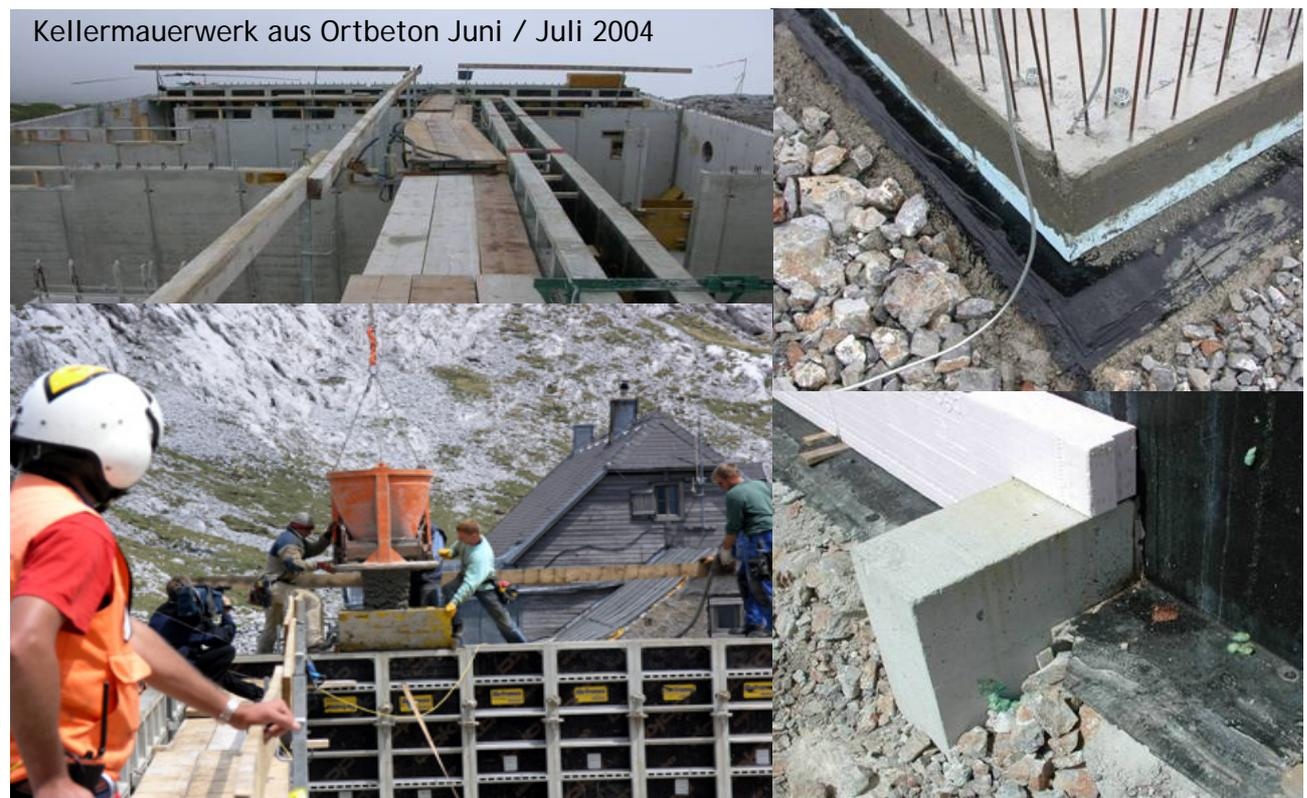
Abbildungen: Links: Betonieren mit Hilfe des Hubschraubers.
