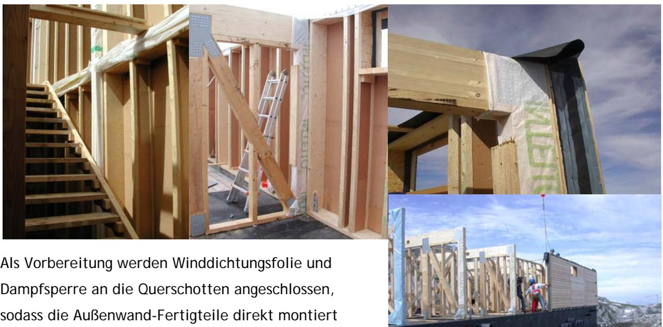
Als Vorbereitung werden Winddichtungsfolie und Dampfsperre an die Querschotten angeschlossen, sodass die Außenwand-Fertigteile direkt montiert werden können.
