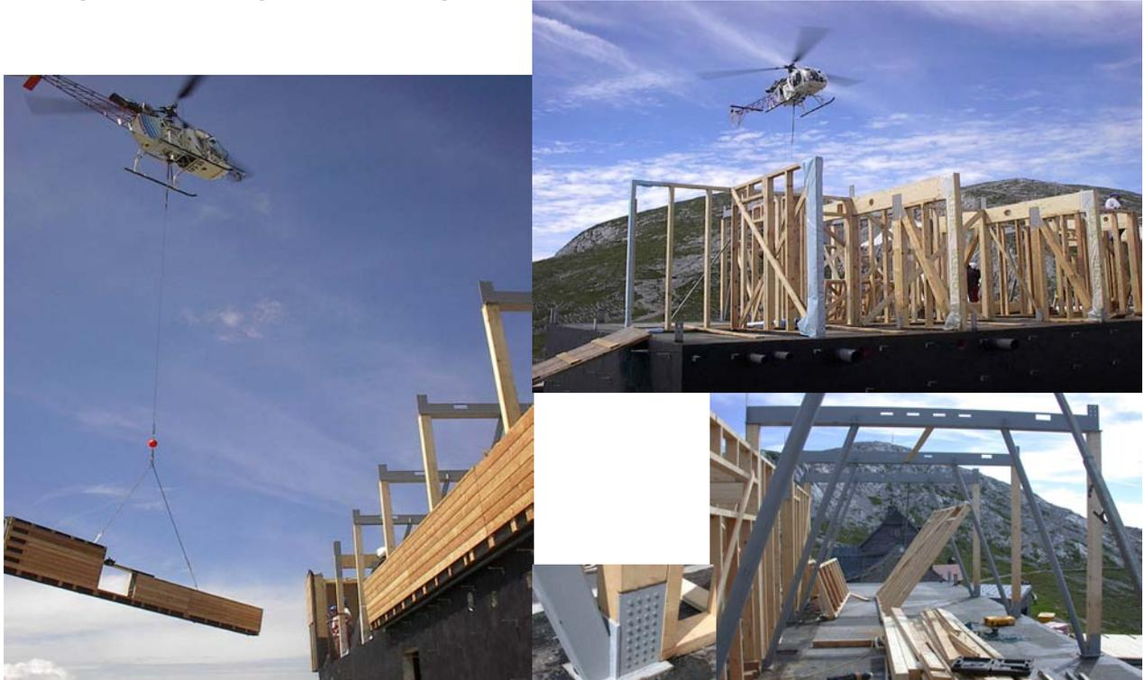
Alle Fertigteile wurden zunächst von der Edelbodenalm zum Bauplatz geflogen und zwischengelagert. Innerhalb kurzer Zeit wurden die Außenwandelemente pro Geschoß versetzt. Der Hubschrauber fungierte "als fliegender Kran".
