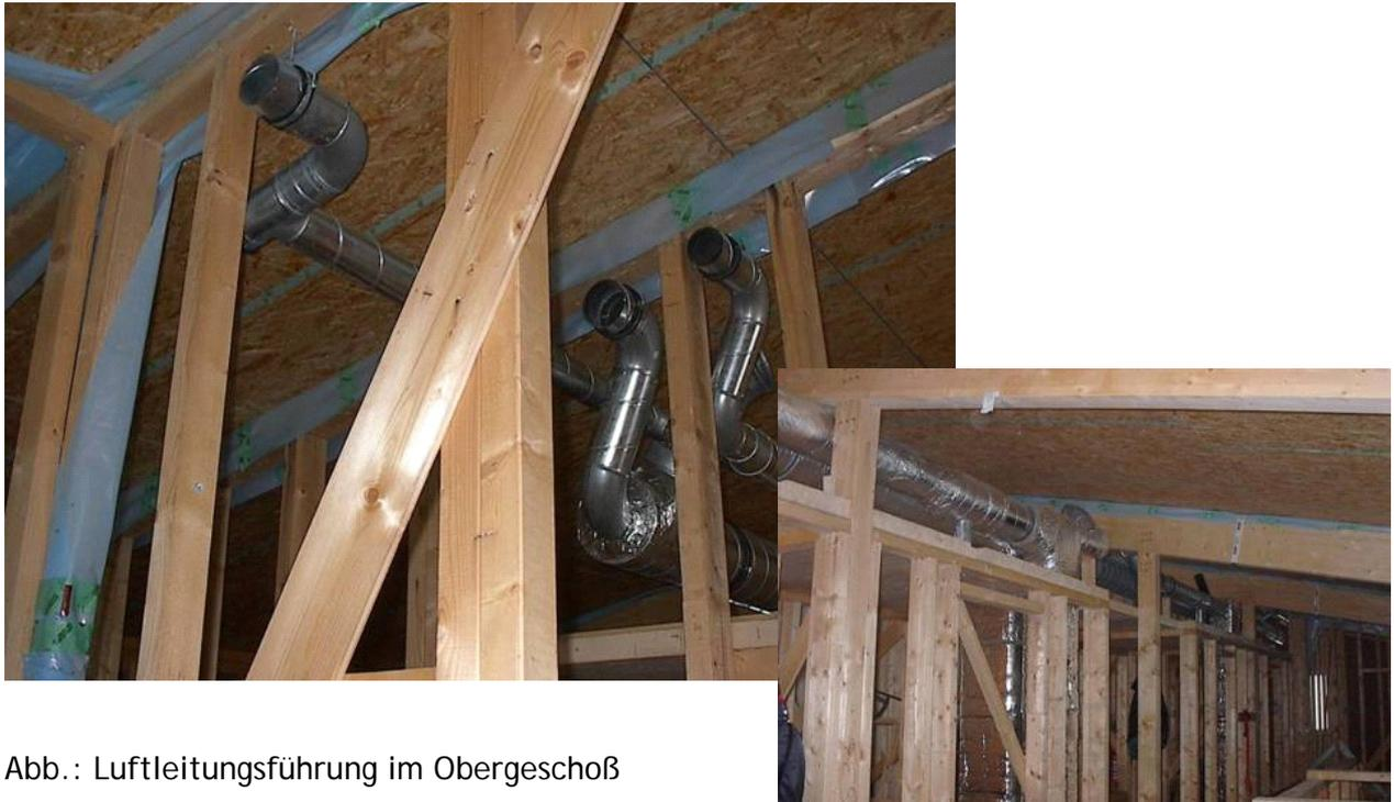
Abb.: Luftleitungsführung im Obergeschoß
