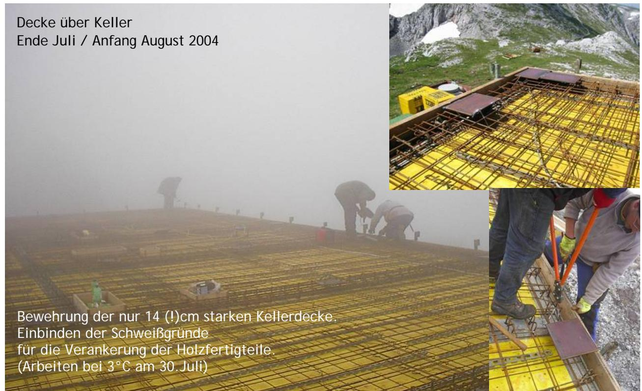
Aus Gründen der Gewichtsersparnis wurde die Decke nur 14cm stark bemessen. Dies brachte große Schwierigkeiten beim Eisenbinden mit sich, da für die beiden Bewehrungslagen nur 14cm zur Verfügung standen. Dazu kam die Erfordernis, die Verankerungsplatten für den aufgehenden Holzbau zusätzlich einschweißen.
