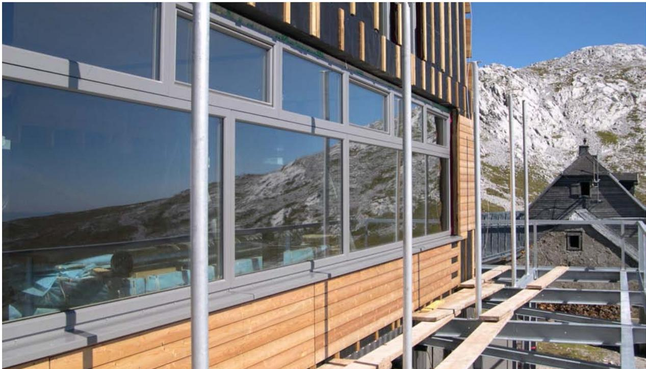
Abb.: Fertige Verglasung der Südfront mit altem Schiestlhaus.
