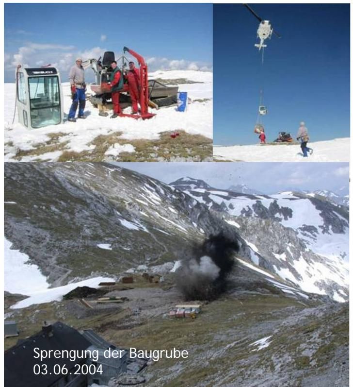
Die erste Phase der Bauarbeiten war durch extrem schwierige Wetterbedingungen geprägt. Bedingt durch starke Schneefälle und Sturm kam es bereits zu Verzögerungen. Der Baugrubenaushub konnte somit erst Anfang Juni stattfinden. Ein Teil des Aushubs erfolgte durch Sprengung.
