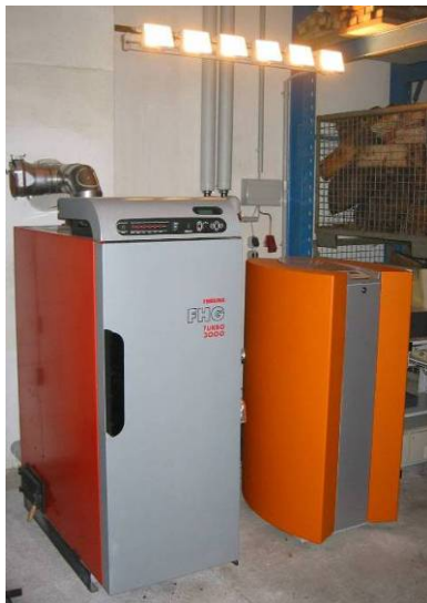
Abbildung 63: Gesamtanlagenkonzept Bison Plus
