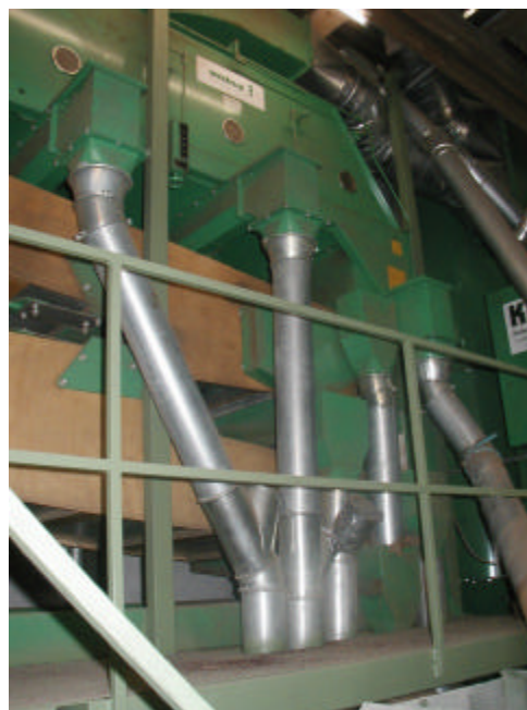
Abb. 11: Frontansicht der Sichtanlage der PSO Buchgraber in Auersbach (Gutaufgabe oben, darunter 2 Siebbehälter und die Rohrleitungen für das Gebläse)
