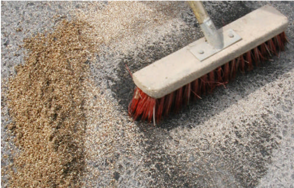
Abb. 82: Fall B – mineralischer Ölbinder wird nach MAG 0/20 eingekehrt
