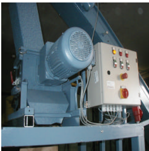
Abb. 59: Schalt- und Steuerkasten sowie Motor der Schneidmühle Romatec 20/26
