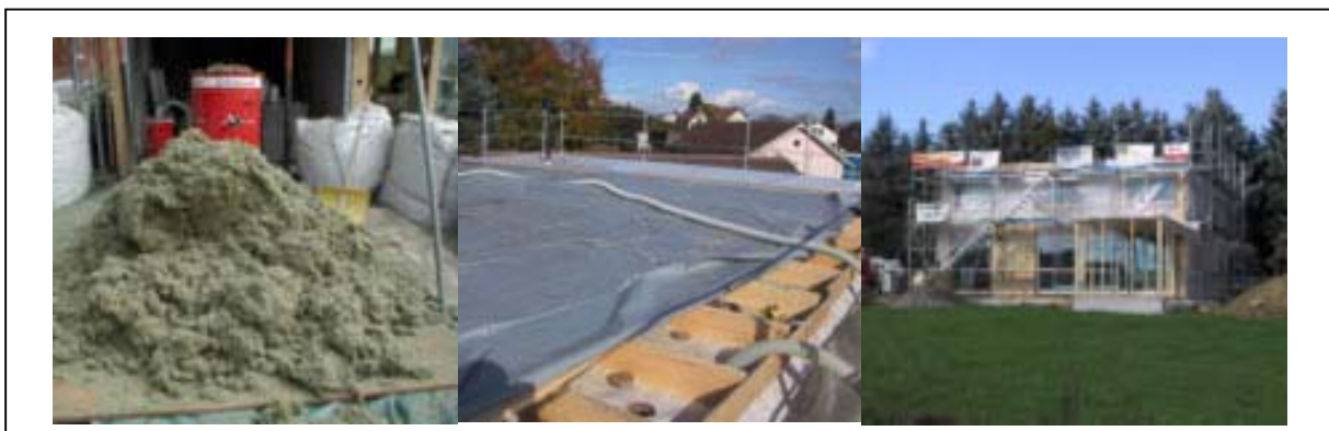
Abb. 3.2.1-2: Dachdämmung mit dem von der schweizerischen Firma „2B-AG“ stammenden Einblasdämmstoff aus Gras [2B-AG 2002].
