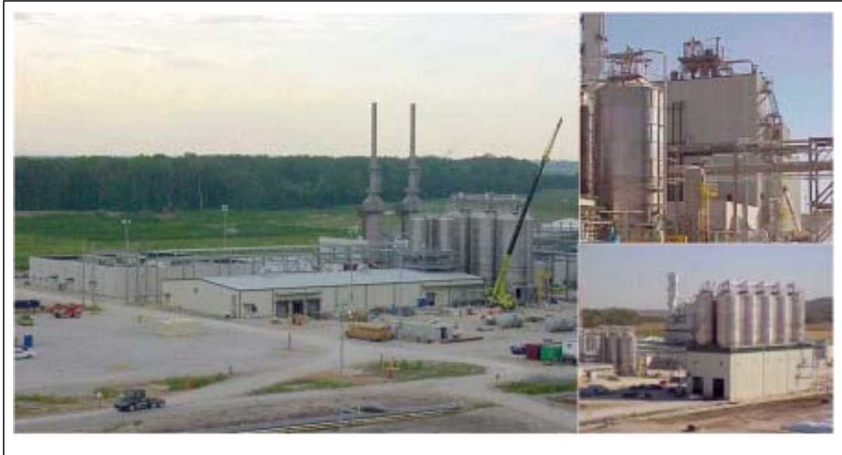
Abb. 1-7: Weltweit erste großtechnische Anlage der Firma Cargill-Dow LLC (USA) zur biotechnologischen Produktion von Milchsäure aus Maisstärke. Kapazität: 140.000 Tonnen/Jahr [ Cargill-Dow 2002 ].
