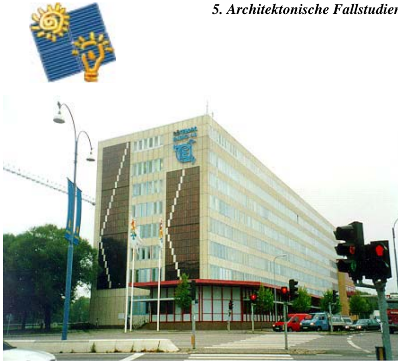
Abbildung 5.15 Die Solaranlagen schließen auch Stahlplatten mit ein, um ein dekoratives Muster zu bilden. Die linke Solaranlage ist 21 m hoch und 5m breit
