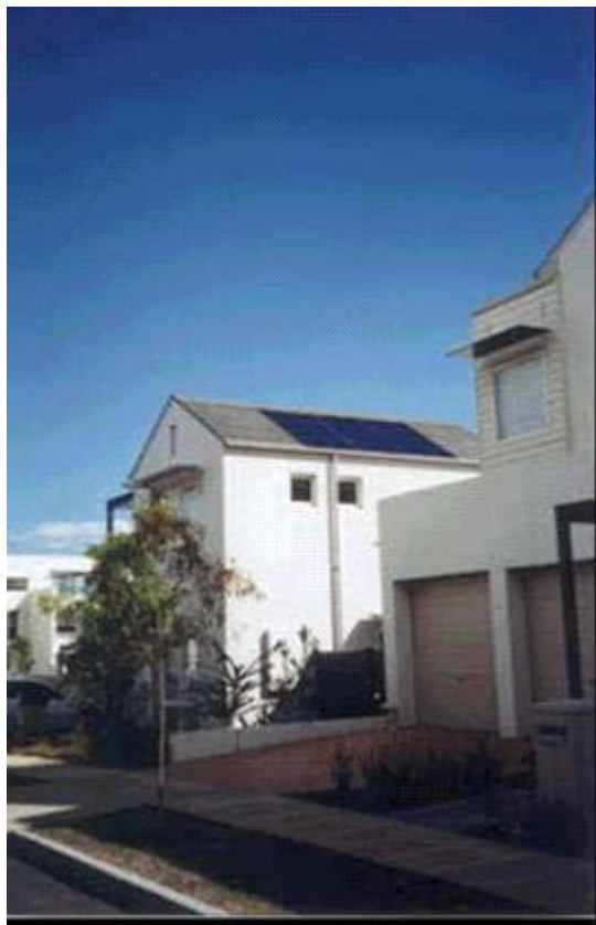
Abbildung 5.1: Dachintegriertes PV-System
