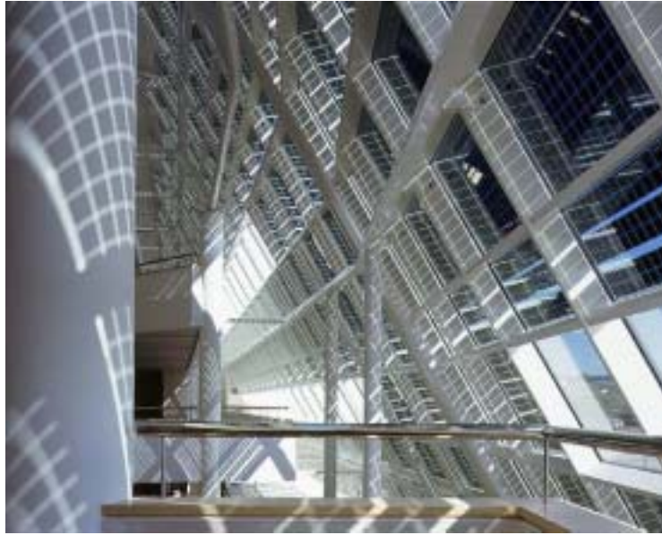
Abbildung 5.7: Die Solarfassade zeigt den Effekt, den Glas/Glas-Module auf die Innenräume haben können, wenn die Sonne scheint. Quelle: Dennis Gilbert Photographer
