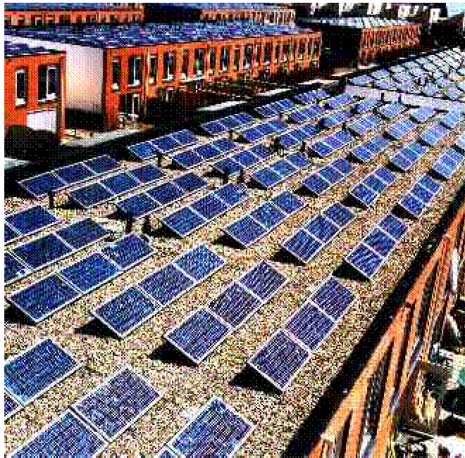
Abbildung 5.12: Aufständigung der PV-Module auf die Flachdächer. Es wurde eine leichte, umweltverträgliche und kostengünstige Kunststoff-Aufständigung eingesetzt.
