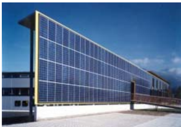
Abbildung 5.4: PV-Südfassade. Quelle: Stromaufwärts
