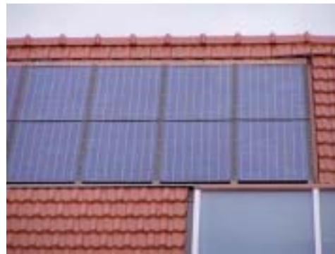
4) Fertige PV-Indachmontage
