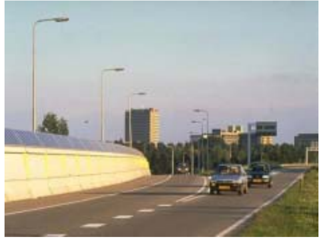
Abbildung 5.24: Lärmschutzwand Credit: Riesjard Schropp (Ecofys)
