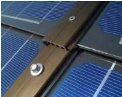
3) Detail der Modulfixierung
