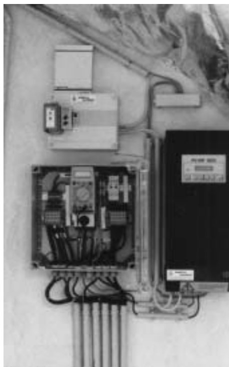
Abbildung G.1.4: Schaltschrank, Wechselrichter (PV-WR 1800)
