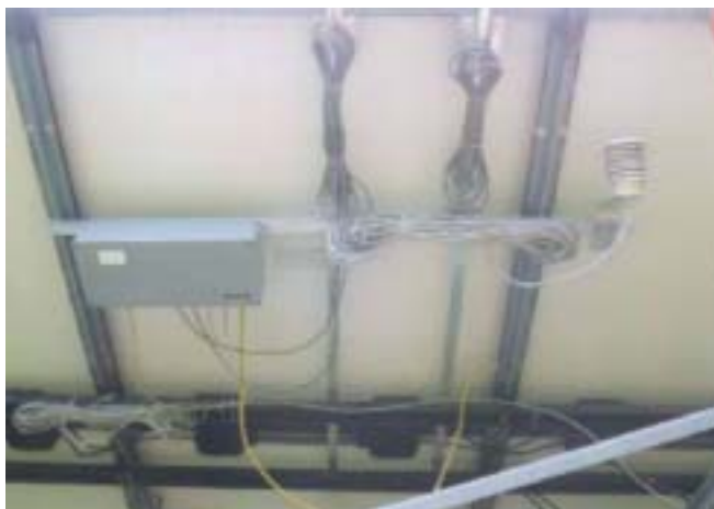
Abbildung G.2.13: Verdrahtung Modulrückseite + Temperaturfühler
