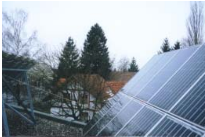
Abbildung G.2.1: Aufgeständerte PV-Module
