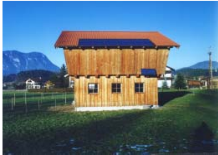
Abbildung G.2.7: Gebäude und PV-Modul (dachintegriert)
