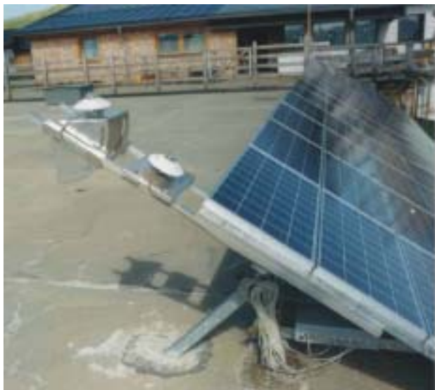
Abbildung G.1.7: PV-Module und 2 Pyranometer (horizontal und in Modulebene)
