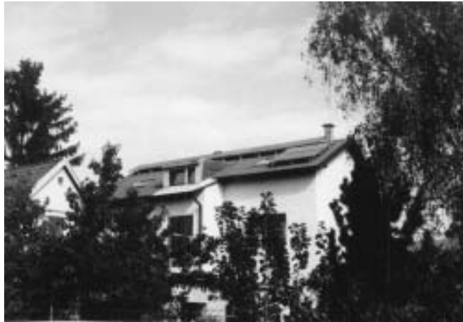
Abbildung G.1.3: Gebäudeansicht mit PV-Modul
