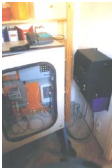
Abbildung G.3.10: Schaltschrank und Wechselrichter
