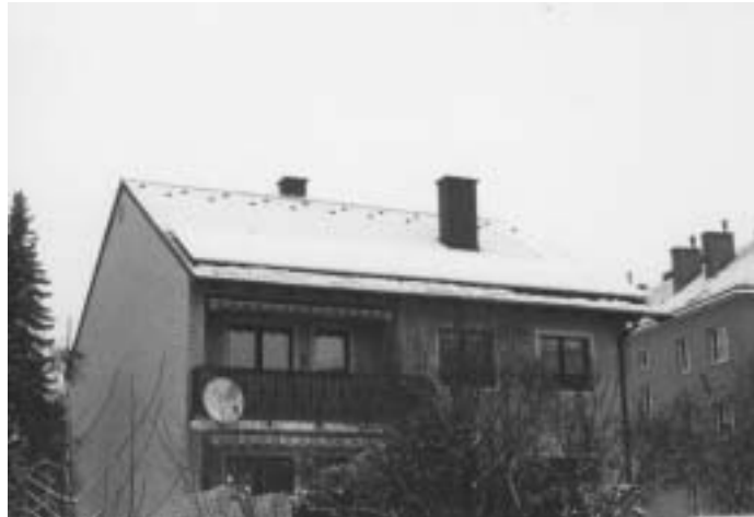
Abbildung G.2.9: Gebäude mit PV-Modul (schneebedeckt)
