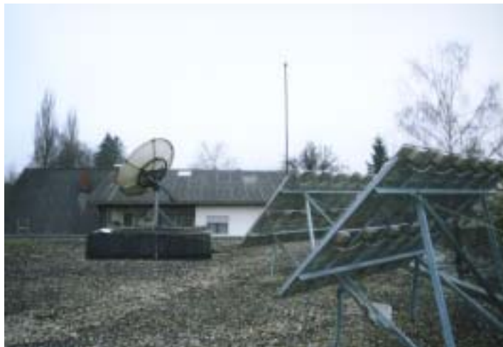
Abbildung G.2.2: PV-Module (Rückansicht)
