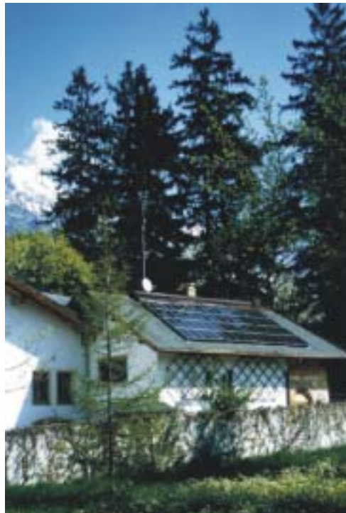
Abbildung G.1.11: Gebäude mit dachintegriertem PV-Modul
