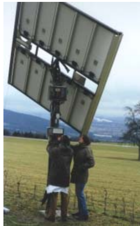
Abbildung G.1.9: PV-Modulansicht (Rückseite) + Montagevorrichtung
