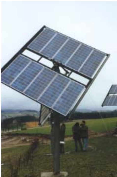
Abbildung G.1.10: PV-Modulansicht (nachgeführte Anlage)
