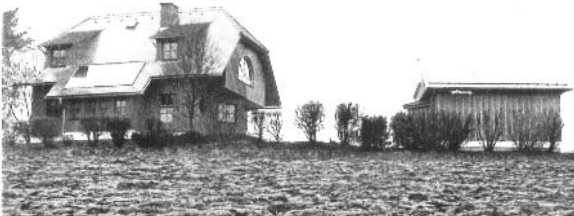
Abbildung G.1.8: Gebäudeansicht mit PV-Modul (dachintegriert)
