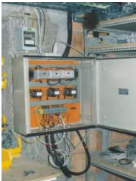
Abbildung G.1.13: Schaltschrank
