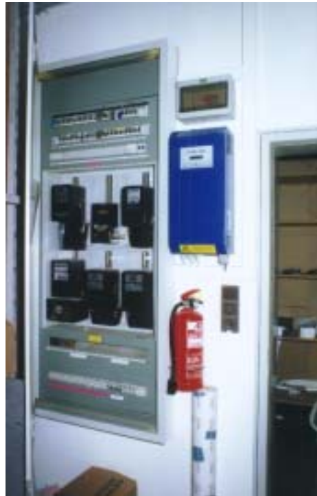
Abbildung G.2.3: Schaltschrank (Zähler) + Wechselrichter
