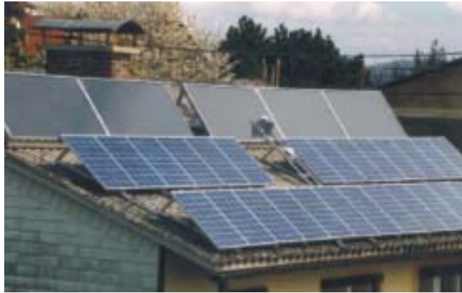
Abbildung G.3.3: PV-Module am Dach aufgeständert (in der Mitte die beiden Pyranometer)
