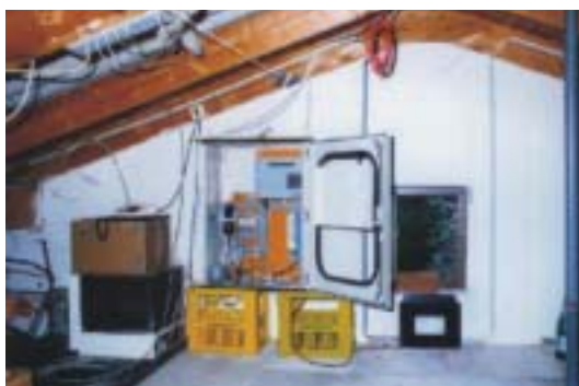
Abbildung G.3.6: Wechselrichter und Messschrank (Dachboden)
