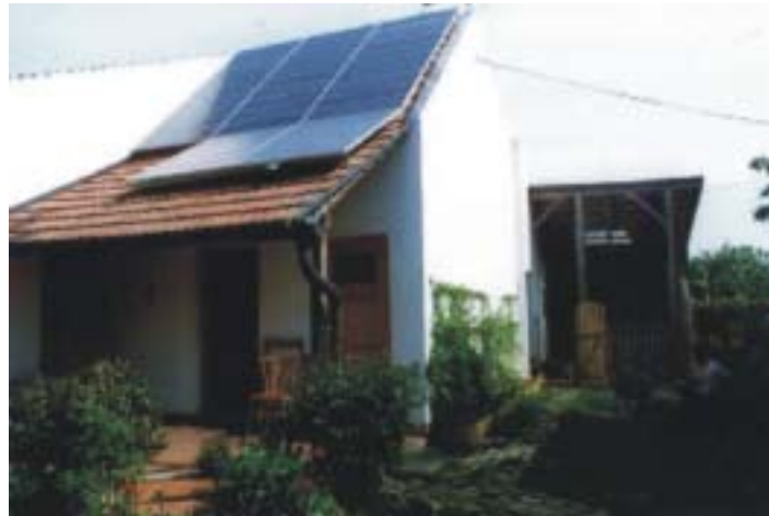
Abbildung G.3.1: Gebäude und PV-Modul
