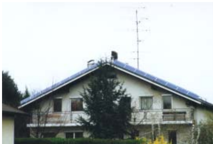
Abbildung G.3.12: Ansicht Gebäude und PV-Module (2 unterschiedliche Orientierungen!)
