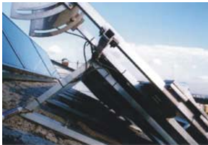
Abbildung G.3.4: Tragekonstruktion für Module
