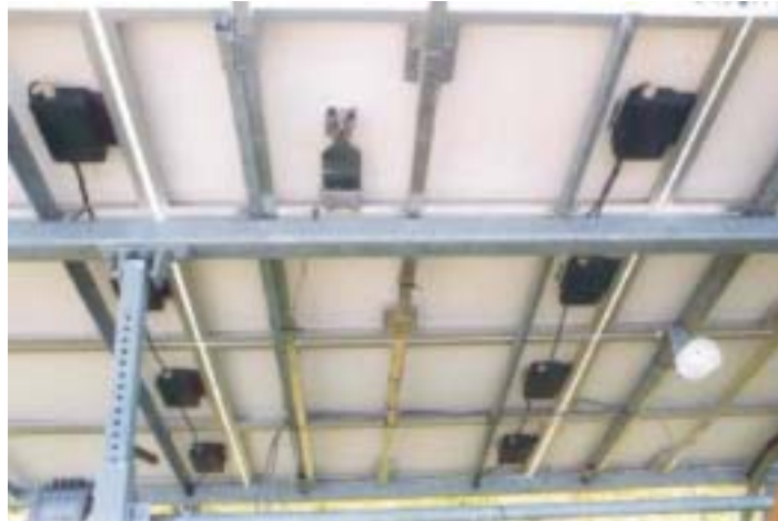
Abbildung G.3.9: Verkabelung Rückseite PV-Modul
