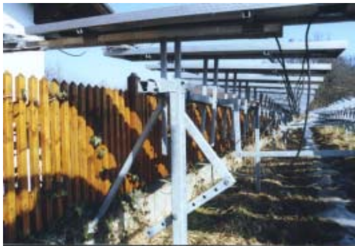
Abbildung G.2.6: PV-Modulansicht (Unterseite) und Montagevorrichtung
