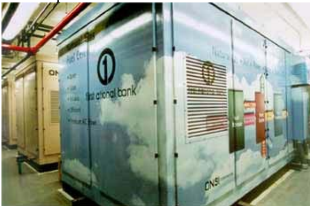
Abbildung 19 Ansicht der PC25-C (200 kW el ) von ONSI (Quelle: IFC) Die PC25-C von ONSI (USA) wird als anschlussfertiger Container ausgeliefert, in dem Brennstoffaufbereitung (Entschwefler, Reformer und Shift-Konverter), Zellstapel, Wechselrichter, Wärmeauskopplung und Brennstoffzellen-Steuerung integriert sind. Für eine Inbetriebnahme sind die Erdgaszuführung (optional auch Flüssiggas-Luft-Gemische), die Stromauskopplung, eine Telefonleitung für die Fernüberwachung seitens ONSI, die Wärmeanbindung und die Stickstoffversorgung (Inertisierung bei An- und Niederfahrvorgängen) anzuschließen. Außerdem muss der mitgelieferte Kühler an das Containermodul angeschlossen werden.
