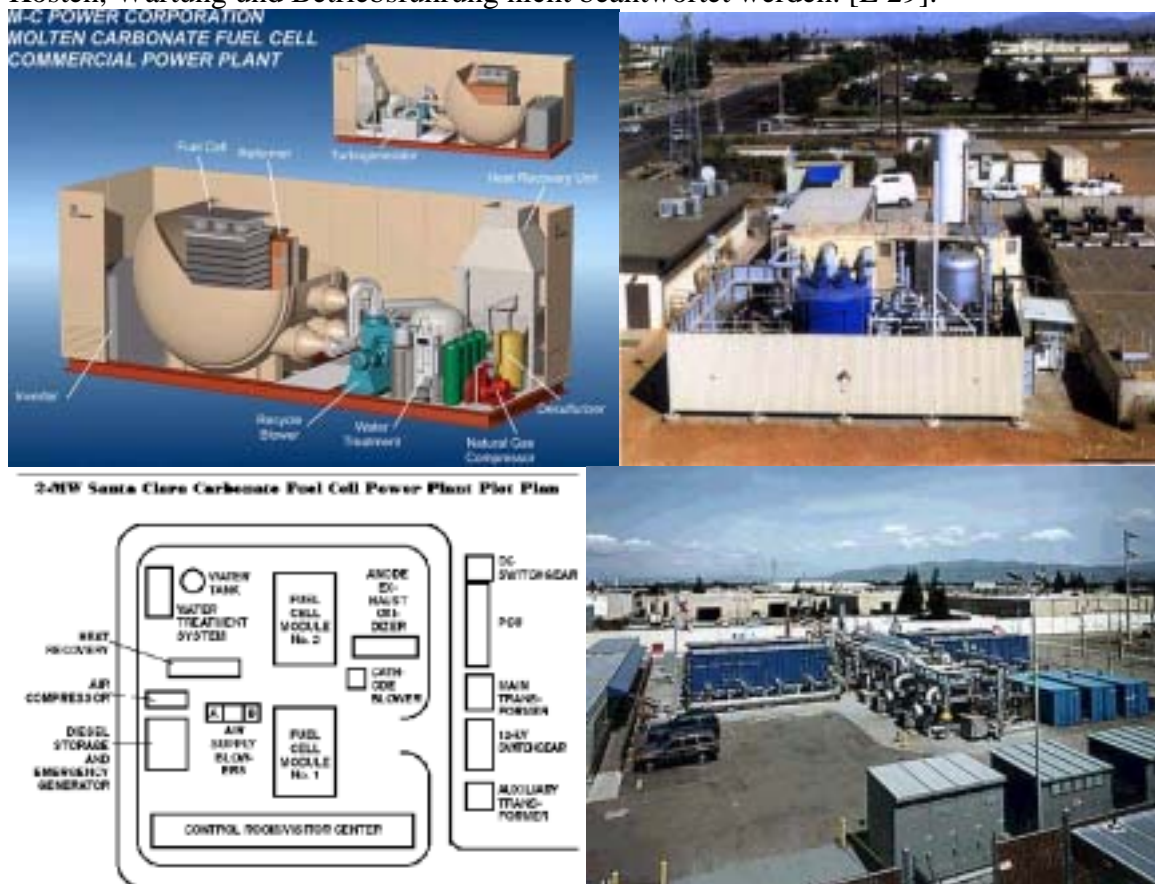
Abbildung 23 Oben: 250 kW el Anlage der Firma MC-Power Unten: 2 MW el Anlage der Firma ERC (Quelle: DOE)
