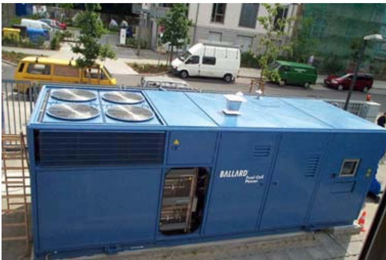
Abbildung 11 250 kW el -Anlage der Firma Alstom Ballard bei der BEWAG in Deutschland (Quelle: Alstom Ballard)
