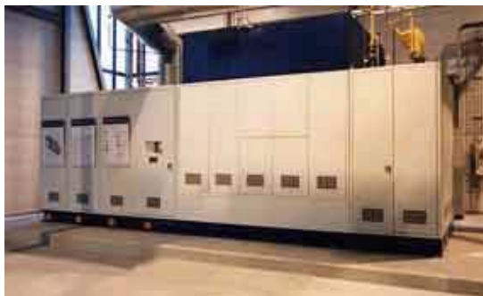
Abbildung 30 Foto und Systemkonzept der 100 kW el Pilotanlage des holländisch/dänischen EVU-Konsortiums in Arnherm, Niederlande (Quelle: Siemens/Westinghouse)
