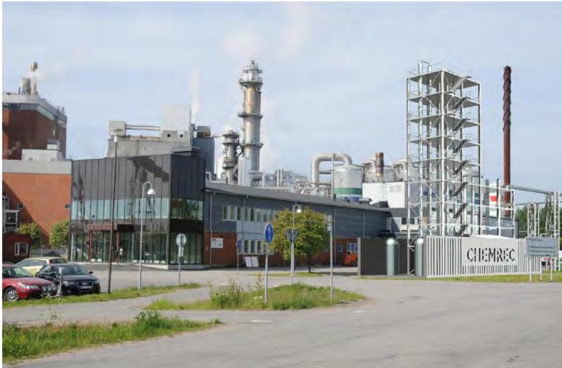
Abbildung 4: DME-Pilotanlage im August 2010
