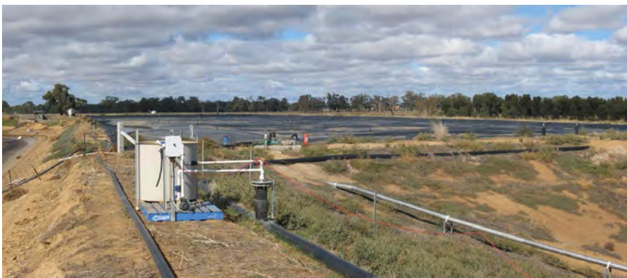
Abbildung 11: Abgedeckte Güllelagune zur Methannutzung
