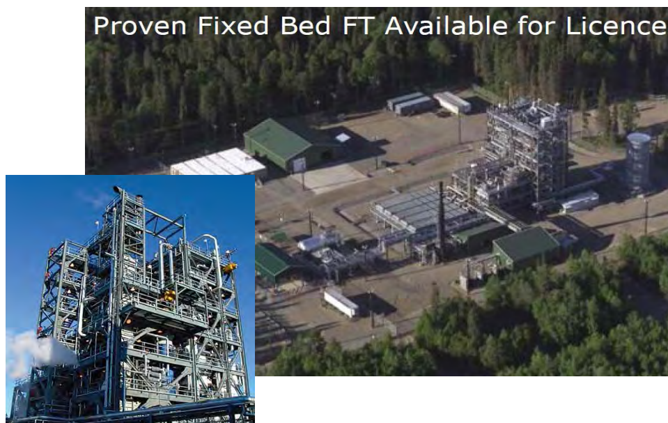
Abbildung 8: Fischer-Tropsch-Pilotanlage der BP in Nikiski, Alaska
