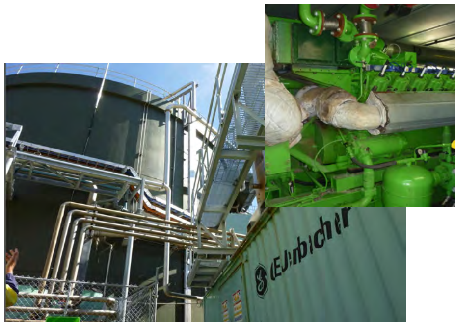
Abbildung 12: Biogasanlage mit Gasmotor-KWK der Jenbacher Werke
