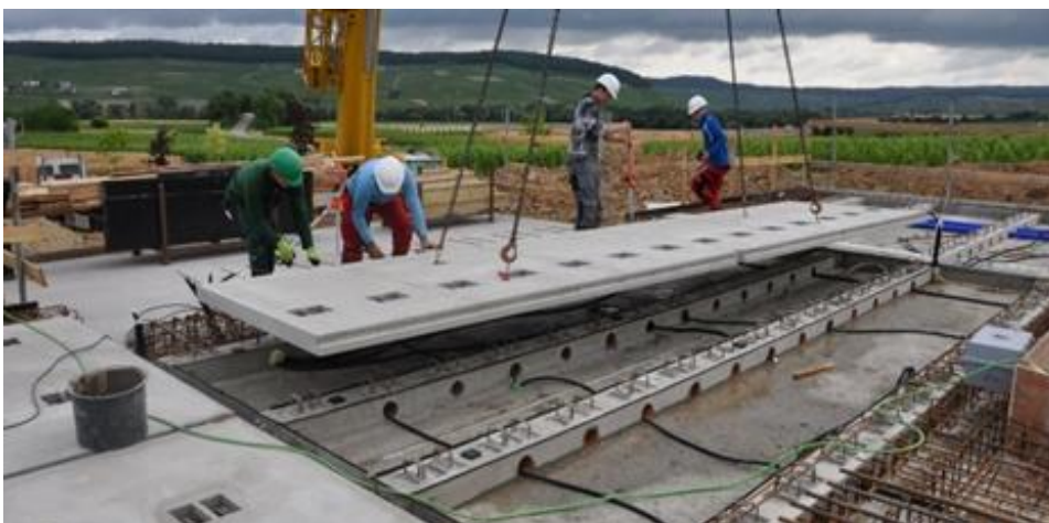
Abbildung 3: Installation einer vorgefertigten CEILTEC Flachdecke mit Sandwichquerschnitt, bestehend aus getrennter oberer und unterer Platte mit Hohlraum. Quelle: Innogration GmbH.
