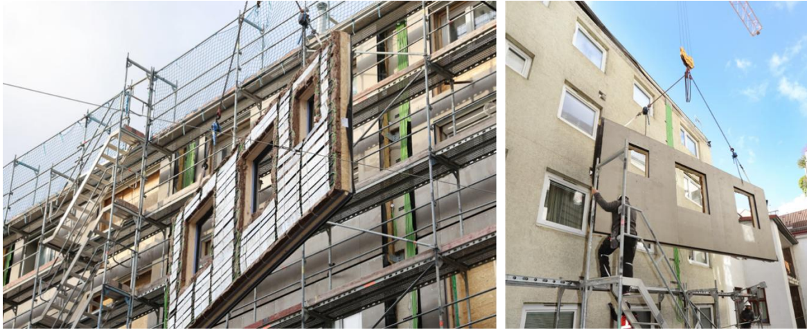
Abbildung 4: CEPA®-Systemdemonstrator am Kran mit sichtbarer thermischer Schicht (links) sowie während der Montage an der Bestandswand (rechts). Quelle: Klima- und Energiefonds, Krobath. Für Österreich ist der Sanierungsbezug besonders relevant. Ein großer Teil des künftigen Gebäudebestands ist bereits errichtet. Speicherpotenziale im Gebäudesektor werden daher nur dann in größerem Umfang erschlossen, wenn Lösungen für bestehende Gebäude verfügbar sind. Außenliegende Systeme können hier einen wichtigen Beitrag leisten, weil sie thermische Sanierung und Aktivierung der Gebäudemasse verbinden. Die Arbeiten im Task knüpfen an österreichische Erfahrungen aus Projekten wie Thermische Fassade, RENVELOPE, CEPA-Connect, EXCESS und HybridLSC an, in denen außenliegende Bauteilaktivierung, vorgefertigte Hüllsysteme und Niedertemperaturversorgung untersucht wurden.
