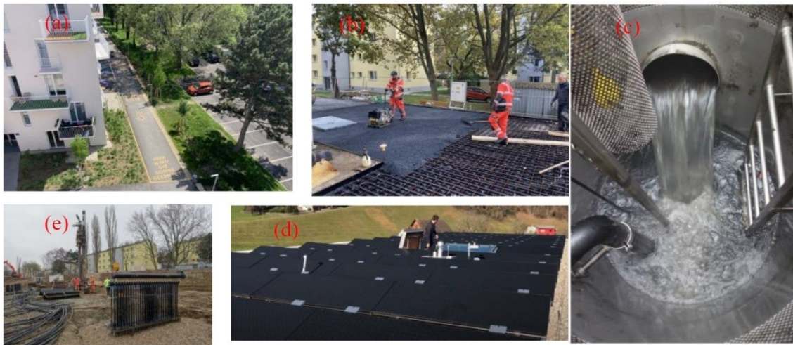
Abbildung 19: Reale Fotos von a) Straße mit Asphaltkollektor (AIT), b) Installation des Asphaltkollektors (AIT), c) Abwasserwärmerückgewinnung (WBV-GPA), d) Solarthermischen Kollektoren (WBV-GPA) und e) Bohrarbeiten für Erdsonden (Quelle: AIT).
