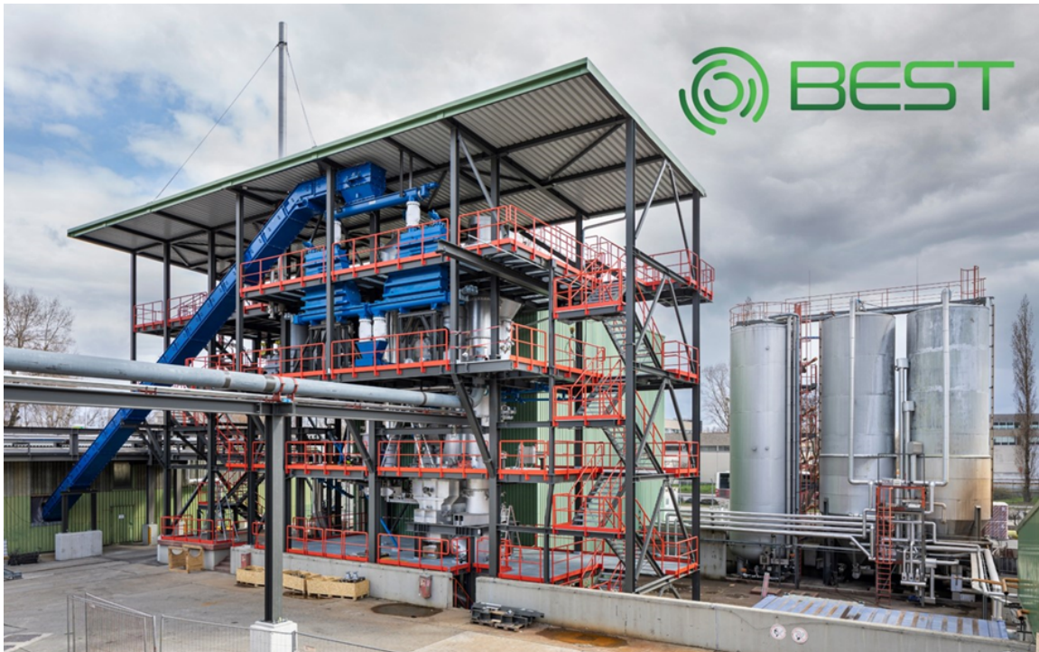
Abbildung 2: Foto des DFB-Gaserzeugers mit doppelter Wirbelschicht (DFB). Die nachgeschaltete Synthese befindet sich in den grünen Hallen im Hintergrund. © BEST, 2021
