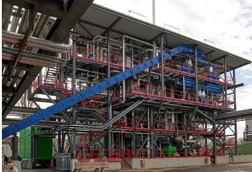
Abbildung 17: Bau der 1 MW-DFB-Gaserzeugungsanlage in Wien Simmering
