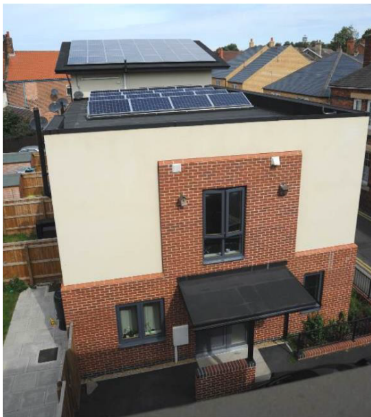
Abbildung 61: Gainsborough Test House. Ansicht von Süden. Quelle: (Sodagar & Starkey, 2016)
