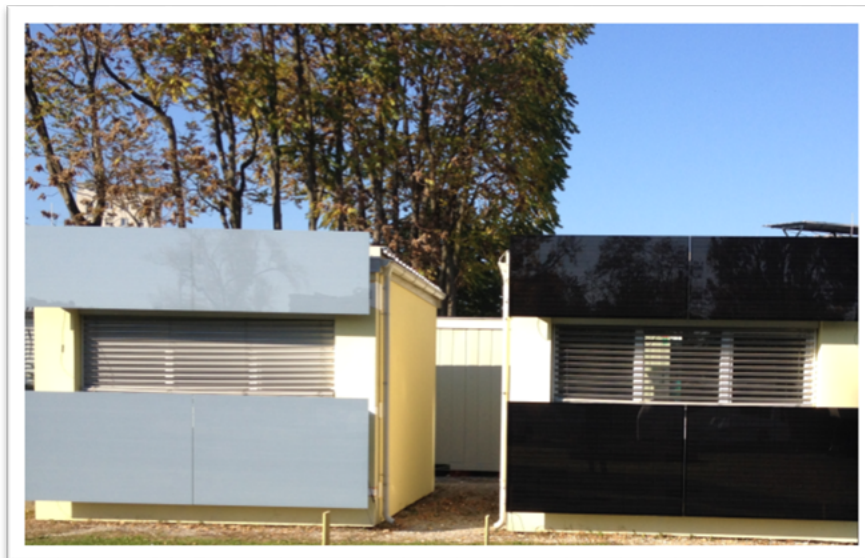
Abbildung 10: Fotografie des Test-Mock-Up der COOLSKIN-Fassade auf dem Testgelände der Technischen Universität Graz (Quelle: TU Graz).
