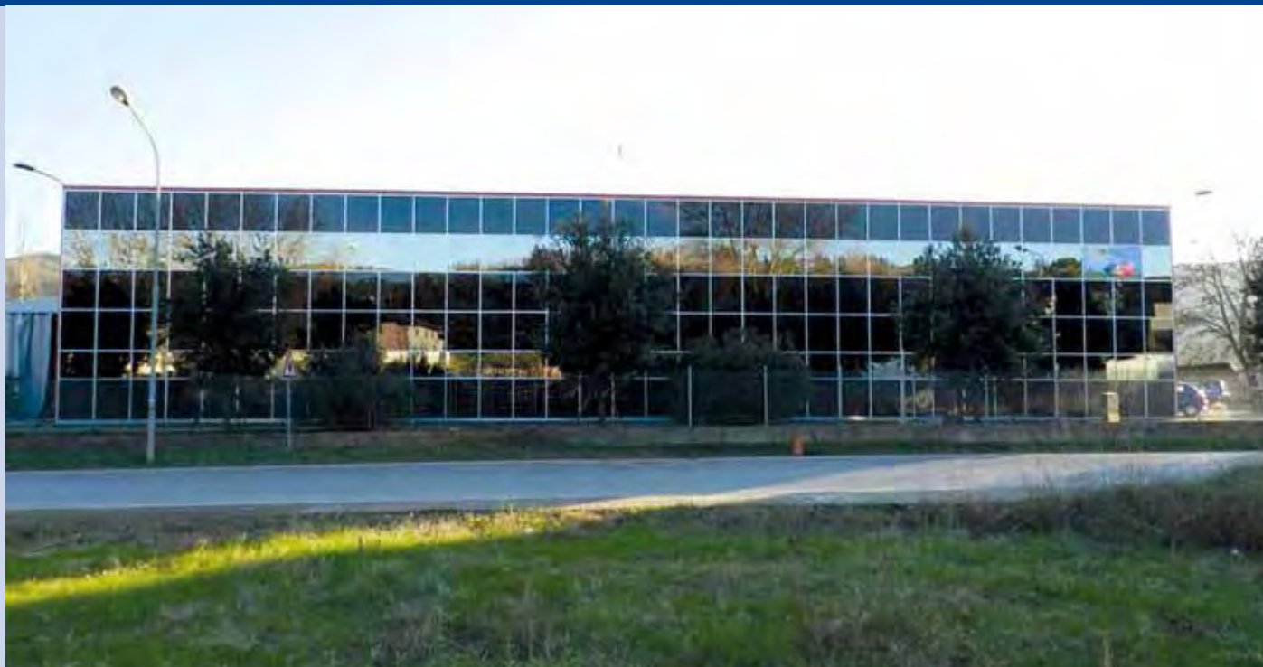
Fig. 1 - 16 kWp PV plant at Panicale (PG), "a-Si/ \mu -Si tandem / thin film" modules (Photo: GSE, Gestore dei Servizi Energetici).
