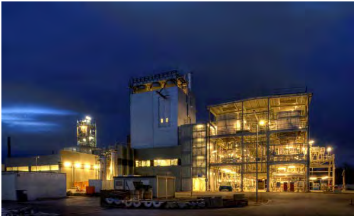
Abbildung 2: Bioliq Anlage - Foto (Quelle: www.bioliq.de )
