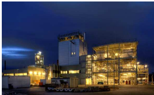
Abbildung 2: Bioliq Anlage - Foto (Quelle: www.bioliq.de )
