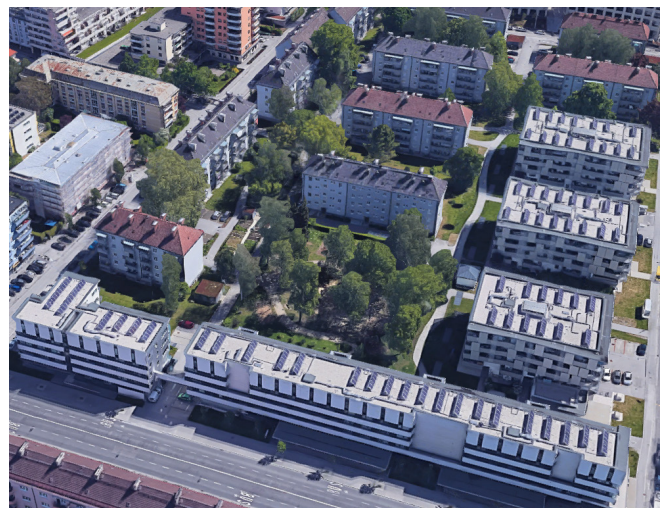
Quartierserneuerung Strubergasse in Salzburg: Eines der „Success Stories“, die im IEA EBC Annex 75 analysiert werden. (Quelle: Google Bilder © 2019 Aerodata International Surveys, GeoBasis-DE/BKG, Geoimage Asutria, Maxar Technologies, Salzburg AG / Wenger Oehn, Kartendaten © 2019)
