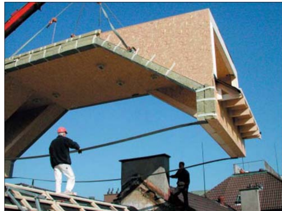
Renovation project Magnusstrasse Zurich, arch. K. Viridén
