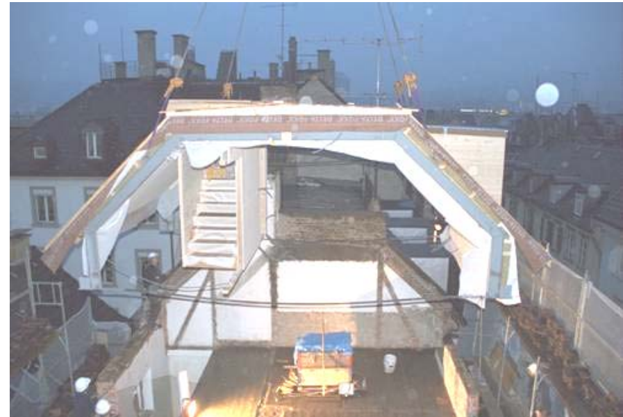
Renovation project Magnusstrasse Zurich, arch. K. Viridén
