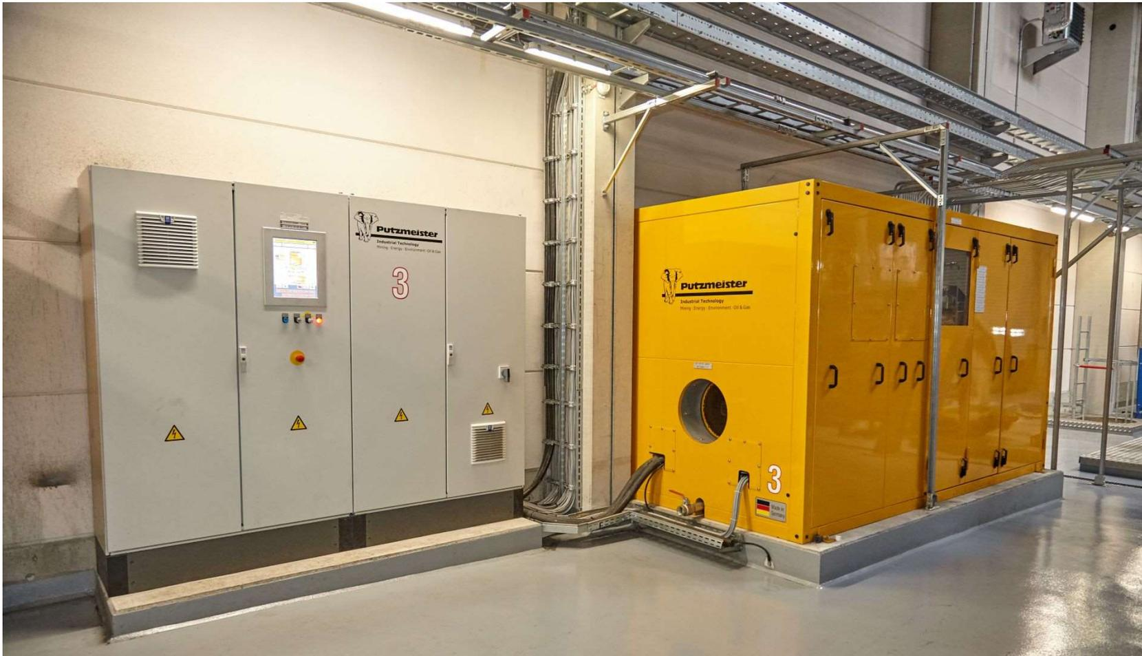
Schaltschrank SEP 200 und Hydraulikaggregat HA 200 mit Schallschutzhaube
