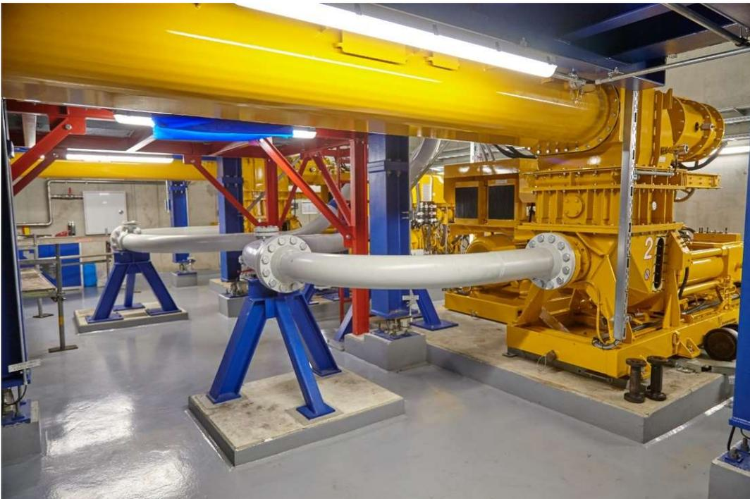
**Annahmehunker** (Ebene -6,50 m) mit Schnecke, Pumpe und Hydraulikaggregat
