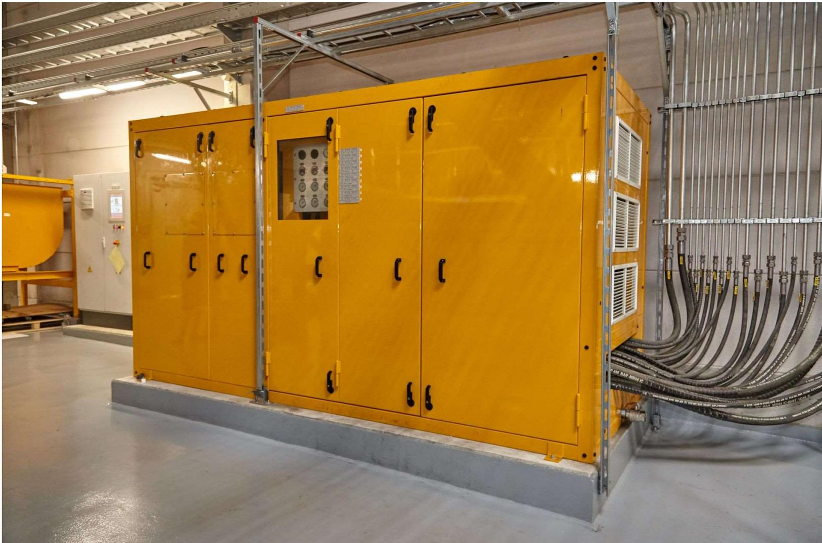
Hydraulikaggregat HA 200 mit Schallschutzhaube
