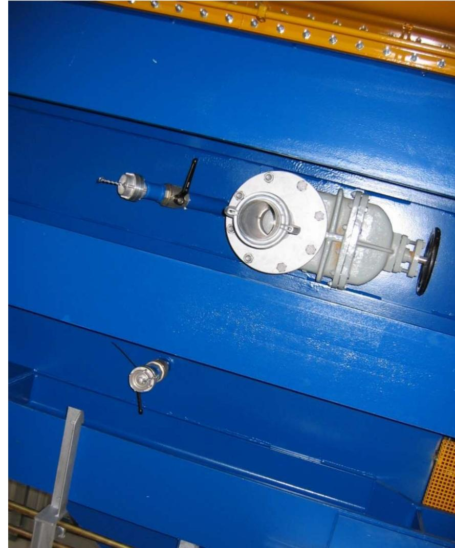
Diverse Spülanschlüsse mit Austragsstutzen DN 200 und Absperrarmatur bzw. Saugwagenanschluss
