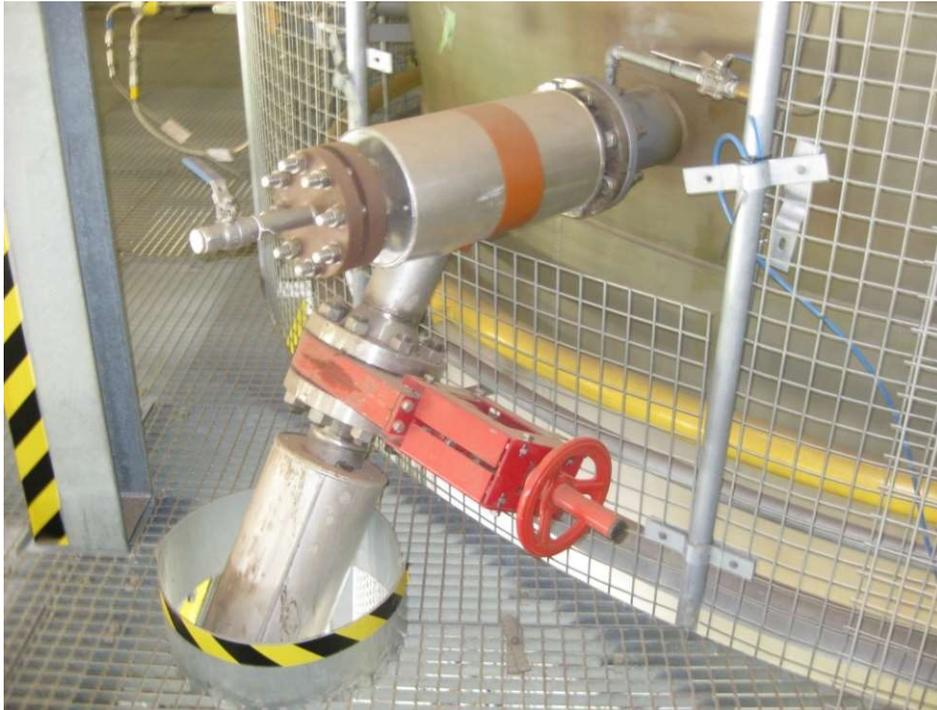
Klärschlamm wird über mehrere über den Umfang verteilte Stutzen auf das Wirbelbett aufgegeben
