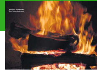
Biomasseerzeugung: Holzheizung nach dem Typen-Charakteristik generaler Biomasseheizwerke vom 1.6.2010 an der ETH Zürich Gut verbrannt heisst sauber verbrannt
