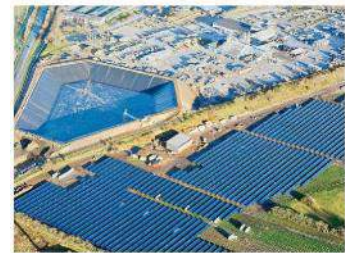
Das Behälterreservoir in Dänemark - die Graz-Anlage könnte ausnahmslos die größte werden
