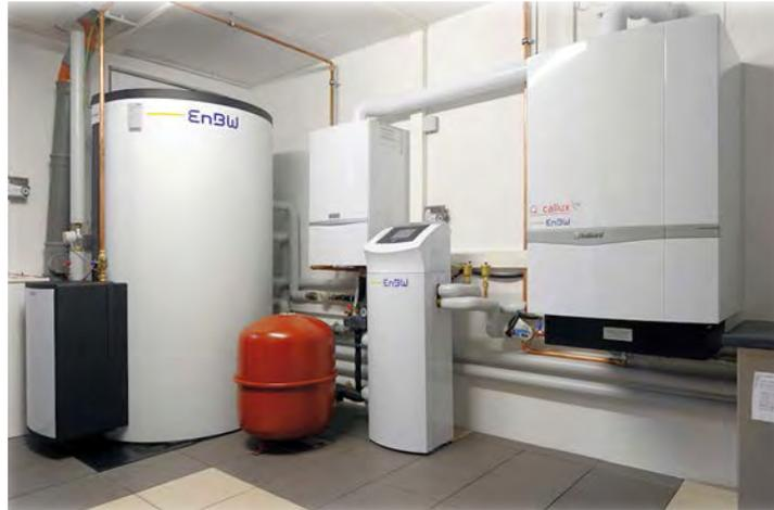
Abbildung 16: Brennstoffzellen-Heizgerät inkl. Pufferspeicher und Spitzenlastkessel der Firma Vaillant (Qu.: Vaillant GmbH)
