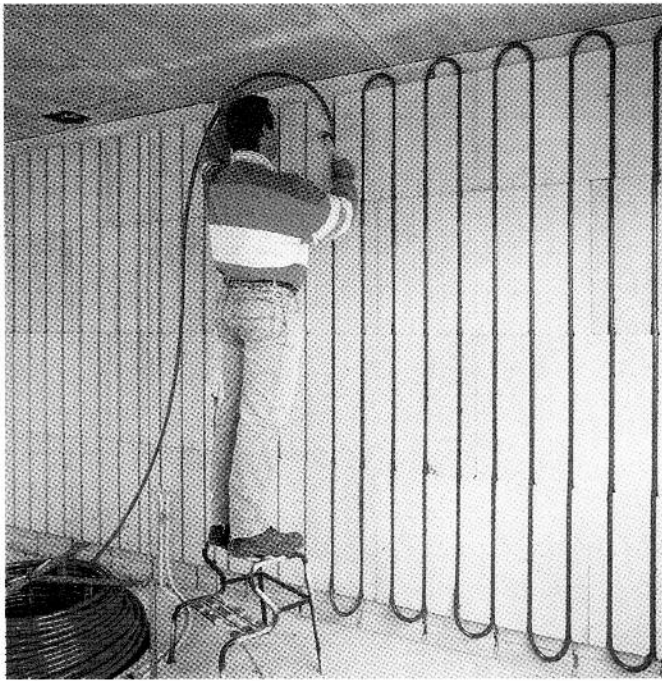
◀ Abbildung 1 Niedertemperatur-Heizsysteme ermöglichen den Einsatz nieder-exergetischer Energieträger
