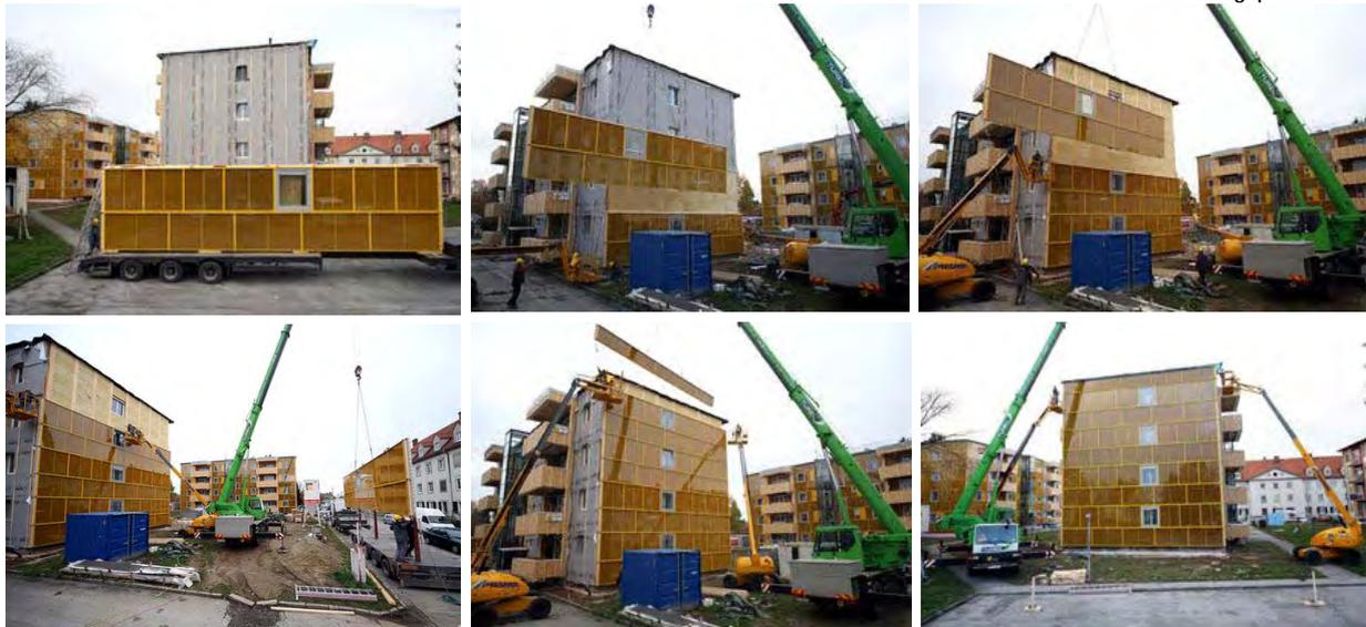
**Abbildung 27: Montage der Fassadenmodule – Dargestellt im Zeitraffer
