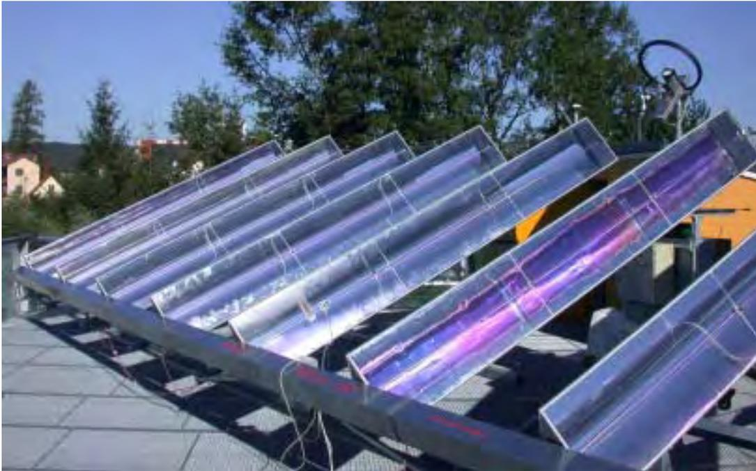
Abb. 8: Pilotanlage mit 10 „Parasol“ Parabolrinnenkollektoren am Teststand der AEE INTEC in Gleisdorf.
