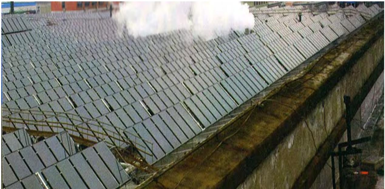
Abb. 4: Die derzeit weltgrößte thermische Solaranlage produziert Prozesswärme für ein Textilunternehmen in Hangzhou, China. Installierte Kollektorfläche: 13.000 m<sup>2</sup> (9 MW<sub>th</sub>)
