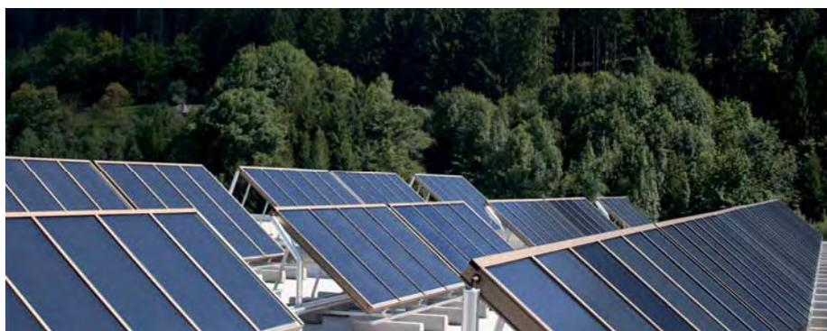
Abb. 10: Die Solaranlage mit einer installierten Leistung von  $150 \text{ kW}_{\text{th}}$  ( $215 \text{ m}^2$  Kollektorfläche) liefert Wärme für Reinigungsprozesse und die Hallentrocknung, Foto: TiSUN®
