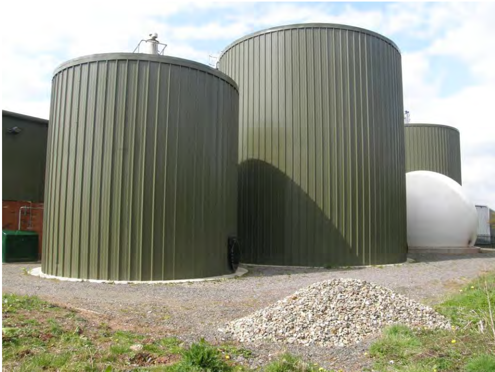
Abb. 3: Biogasanlage der britischen Firma Greenfinch zur Verwertung von getrennt gesammelten Speiseresten und Bioabfällen in Ludlow, UK, mit Biogasreaktoren (Vordergrund), Gasspeicher und Endlager (Hintergrund)
