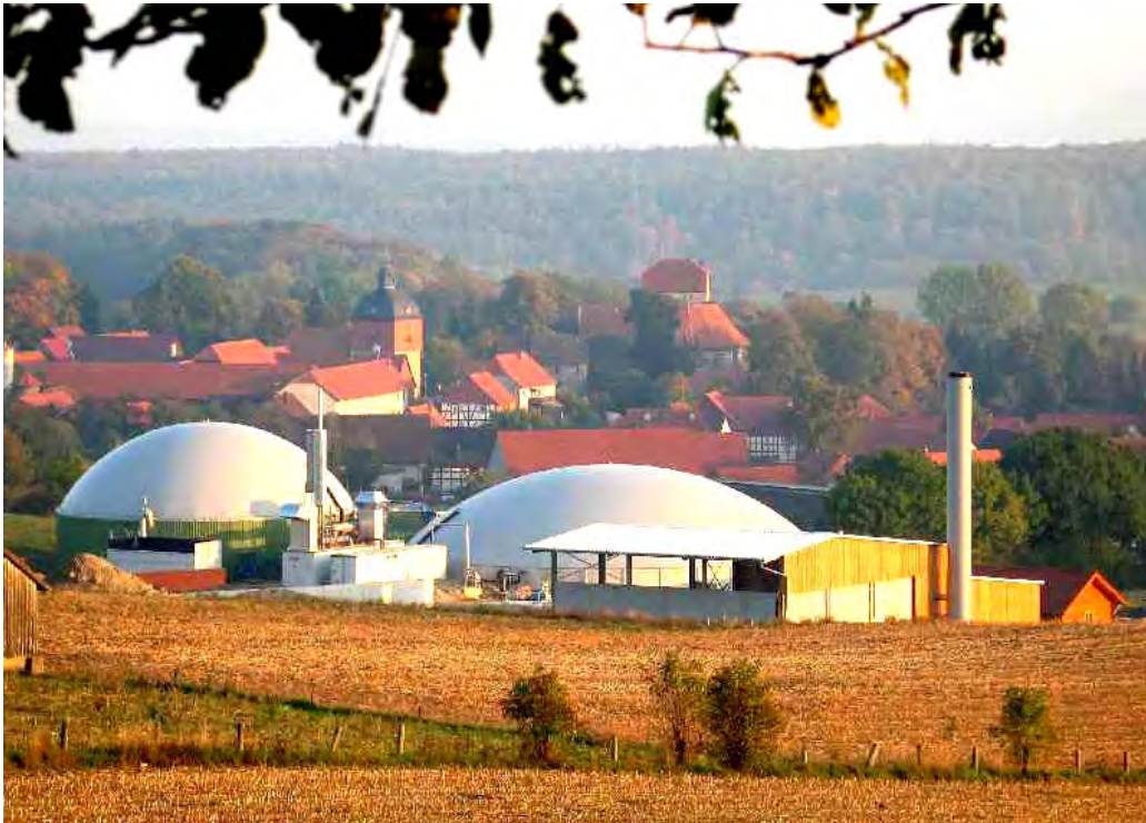
Abb. 16: Biogasanlage Jühnde, Deutschland mit Biogasreaktor (3.000 m 3 ) und Endlager (4.400 m 3 ), Elektrische Leistung 700 kW el , thermische Leistung 750 kW
