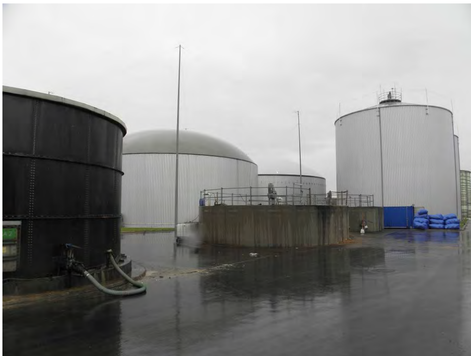
Abb. 8: Biogasanlage Bruck / Leitha mit Biogasreaktoren (Hintergrund) und Substrataufbereitung (Vordergrund)
