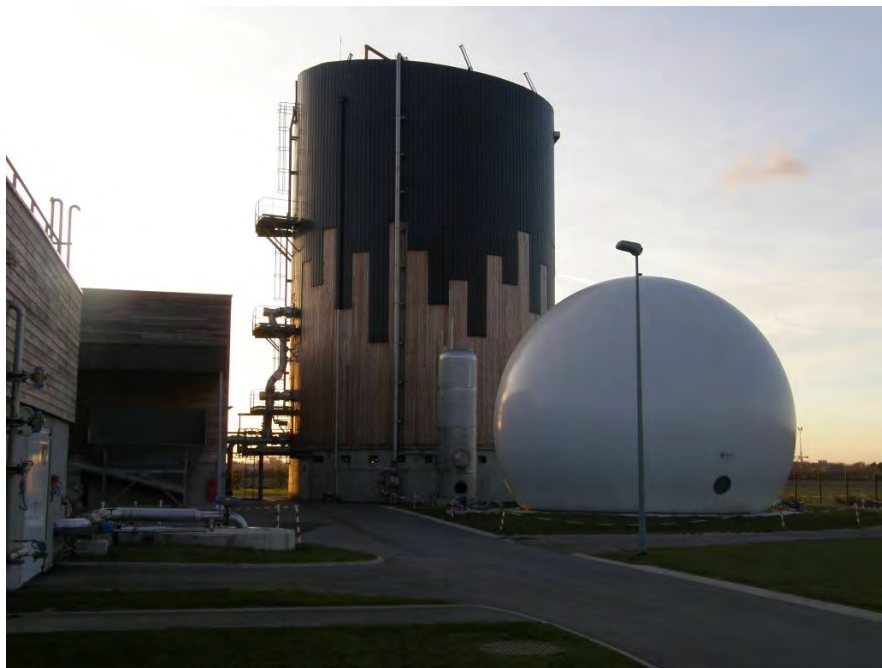
Abb. 2: Valorga Bioabfallbehandlungsanlage in der Stadt Calais mit Gärreaktor (Hintergrund), Betriebsgebäude (links) und Gasspeicher (rechts)
