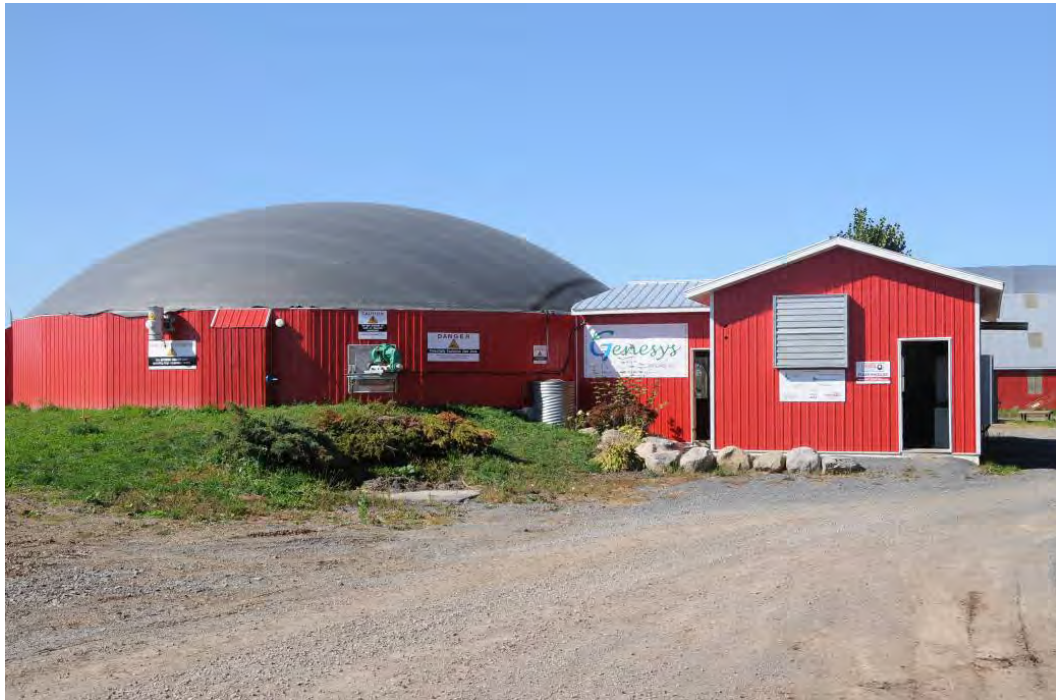
Abb. 4: Landwirtschaftliche Biogasanlage zur energetischen Nutzung von Rindergülle in Ottawa, Kanada mit Biogasreaktor samt flexibler Gasmembran (links) und eingehaustem Blockheizkraftwerk samt Wärmeaustauscher (rechts)
