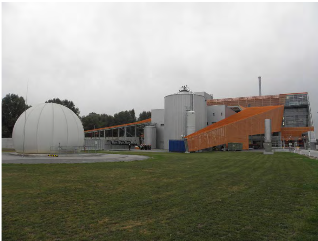
Abb. 6: Biogasanlage Wien mit 400 m 3 Gasspeicher (Vordergrund), Biogasreaktor mit Entschwefelungskolonne (Zentrum) und Verfahrenshalle zur Bioabfallaufbereitung (Hintergrund)
