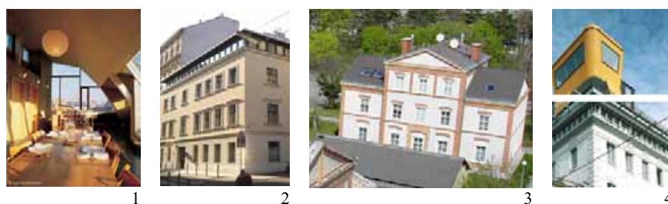
Fig. 4: im Rahmen der Exkursion besichtigte Sanierungsprojekte
