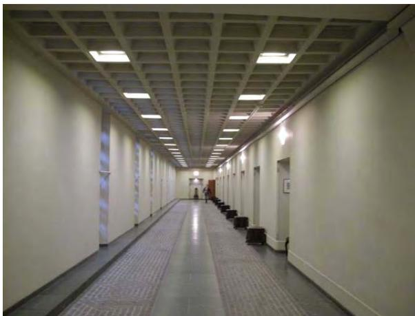
**Figure1 0-35.** *20Wtungstenhalogenlampsabovethe doorsreplacedby2x3WRebelLEDs.*
