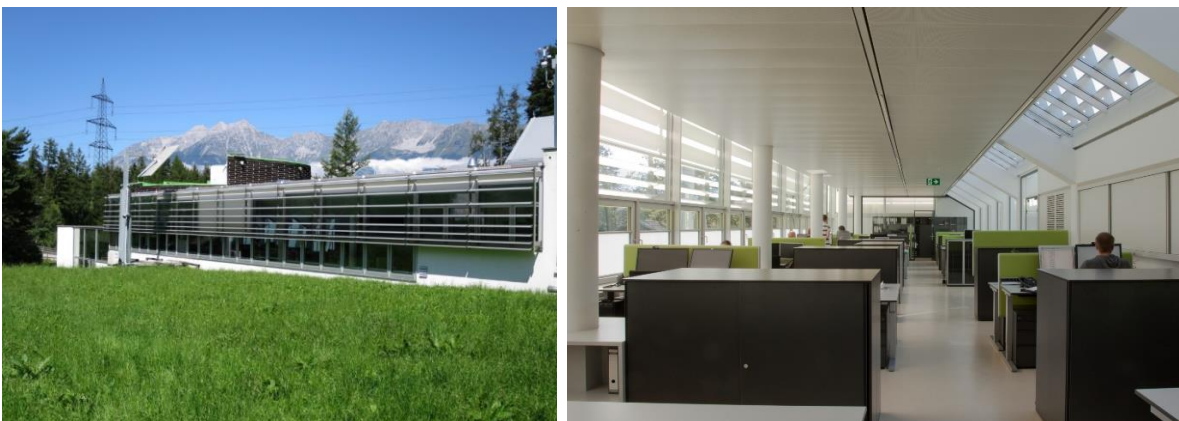
Abbildung 1: Bartenbach F&E Gebäude in Aldrans, Österreich: Außenansicht (links), Innenraum (rechts).
