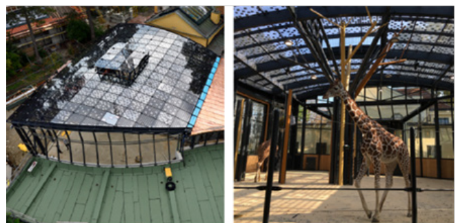
Gebäude mit BIPV Überdachung mit hoher Transparenz (geringe Zellbelegung); Projekt Giraffenhaus, Tiergarten Schönbrunn in Wien; Projekt und Fotos: ertex solartechnik GmbH
