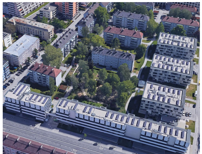
Quartierserneuerung Strubergasse in Salzburg: Eines der „Success Stories“, die im IEA EBC Annex 75 analysiert werden. (Quelle: Google Bilder © 2019 Aerodata International Surveys, GeoBasis-DE/BKG, Geoimage Asutria, Maxar Technologies, Salzburg AG / Wenger Oehn, Kartendaten © 2019)
