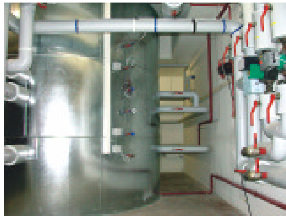
Abbildung 6: Einspeichersysteme reduzieren Kosten und Wärmeverluste entscheidend
