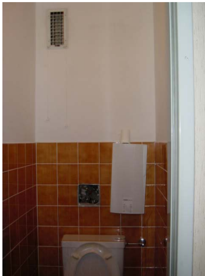
WC Anlage vor Demontage der Wand
