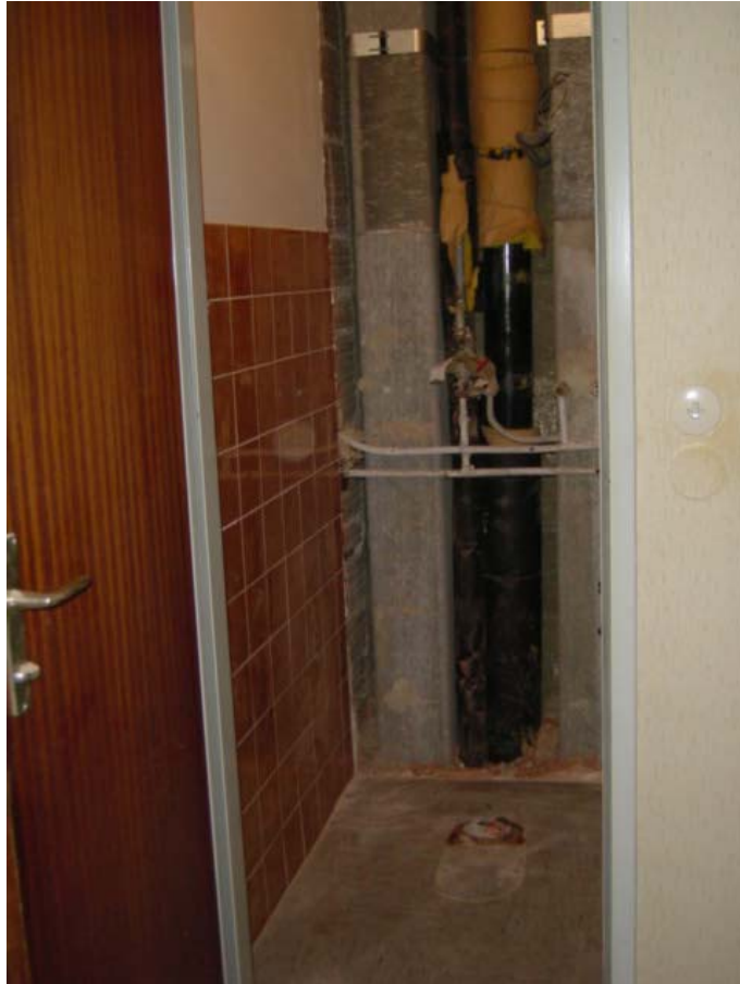
WC nach der Wandmontage.
