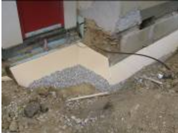
Situation im Eingangsbereich vor Befestigung der vertikalen Perimeterdämmung
