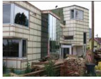
Jetziger äußerer Zustand
