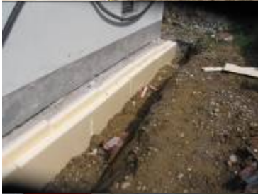
Anbringen der Vertikalen Perimeterdämmung und verfüllen mit Aushubmaterial
