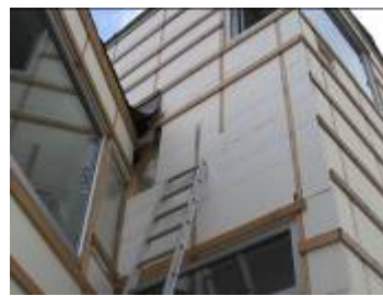
Demontage der Lattung
