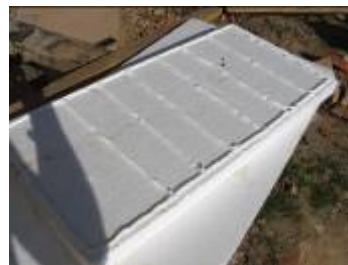
Streifenförmiges Aufbringen des Klebers auf der EPS-Dämmung
