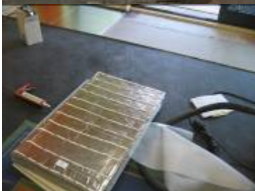
Streifenförmiges Aufbringen des Klebers auf den Vakuumpaneelen
