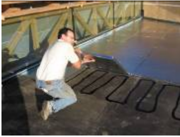
Streifenförmiges Aufbringen des Klebers auf der Bitumenvordeckung und Verlegen der Paneele
