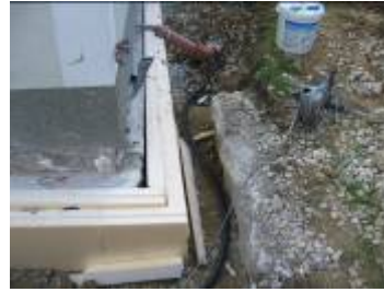
Situation im Eckbereich Alle Fugen mit PU-Schaum verfugt
