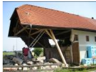
Versuch der Schaffung eines überdeckten Ar- beitsplatzes
