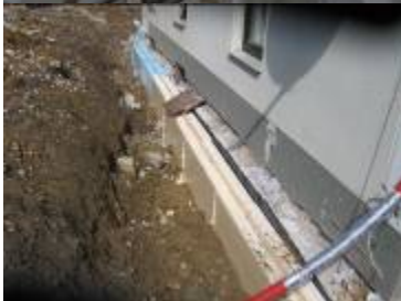
Perimeterdämmung im Bereich des Altbaues
