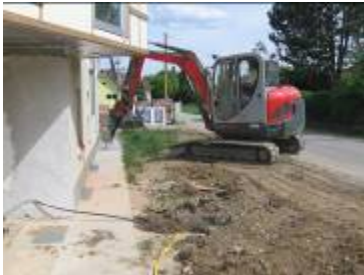
Abbruch der Gret und Ausgraben des Sockelbereiches
