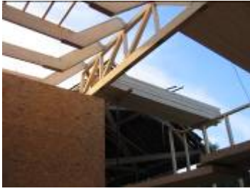
Montage des Zubaues
