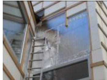
Einsetzen der neuen Paneele
