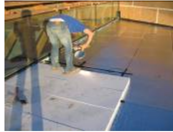
Streifenförmiges Aufbringen des Klebers auf den Vakuumpaneelen und Verlegen der EPS-Dämmung
