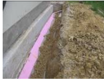
Verlegen der unteren Perimeterdämmung unter ca. 45°, Einbau einer Minidrainage, Vlies unter sichern mit Aushubmaterial (Lehm)
