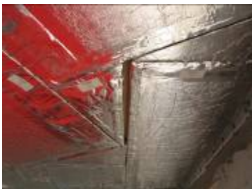
Verklebte Paneele an der Untersicht. Große Toleranz bei dreiecksförmigem Paneel durch Verlegefehler
