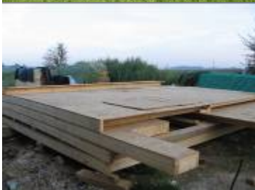
Elementfertigung vor Ort
