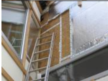
Demontage des EPS und des schadhaften Paneels
