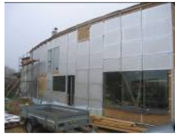
Montage der Vakuumdämmung
