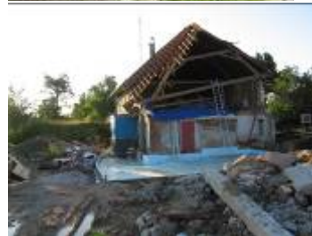
Errichtung der Fundamentplatte für den Neubau
