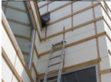
Anbringen von Klemmlatten ,EPS und Fassadenlattung
