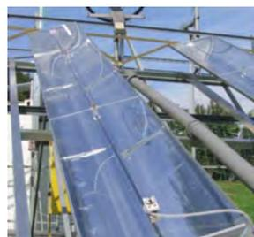
Fig. 38: Parabolrinnenkollektor mit Abdeckung [Weiss et al., 2005].
