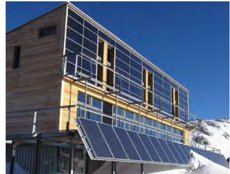
Aufbau Die weitaus meisten Solarzellen bestehen aus Silizium. **Mono- und polykristalline Siliziumzellen** haben heute einen Marktanteil von etwa 80 %. Sie werden als 0,3 mm dicke und 10 cm große Scheiben aus Kristallblöcken herausgesägt und weisen einen vergleichsweise hohen Wirkungsgrad auf (siehe Fig. 42).
