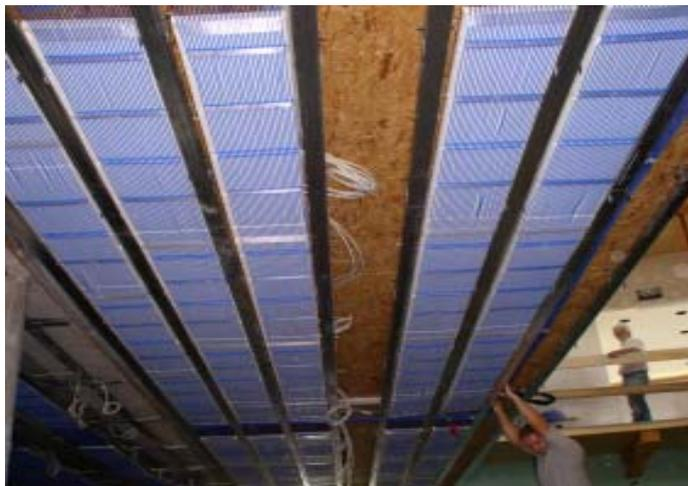
Abb. 4 Installierte Kühldecke [Quelle: TU-Graz]
