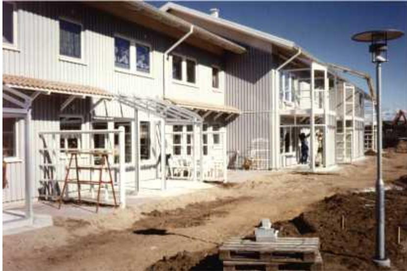
Abb. 33: Ingolstadt-Halmstadt: Niedrigenergiehäuser (30 kWh/(m<sup>2</sup>a) Heizwärmebedarf) in zwei Ländern von Architekt Hans Eek (1985) [Quelle: [www.passivhaustagung.de](http://www.passivhaustagung.de)]
