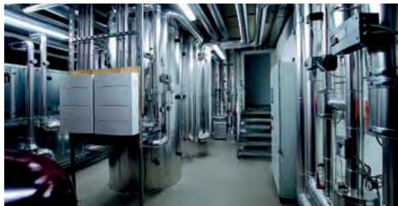
Bild 1: Vollsolar beheiztes Kultur- und Veranstaltungszentrum Hallwang ohne Zusatzheizung 2)
