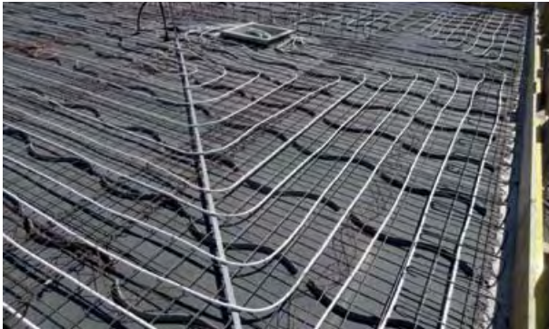
Abbildung 4: Lage der Rohre vor den Betonierarbeiten 1)
