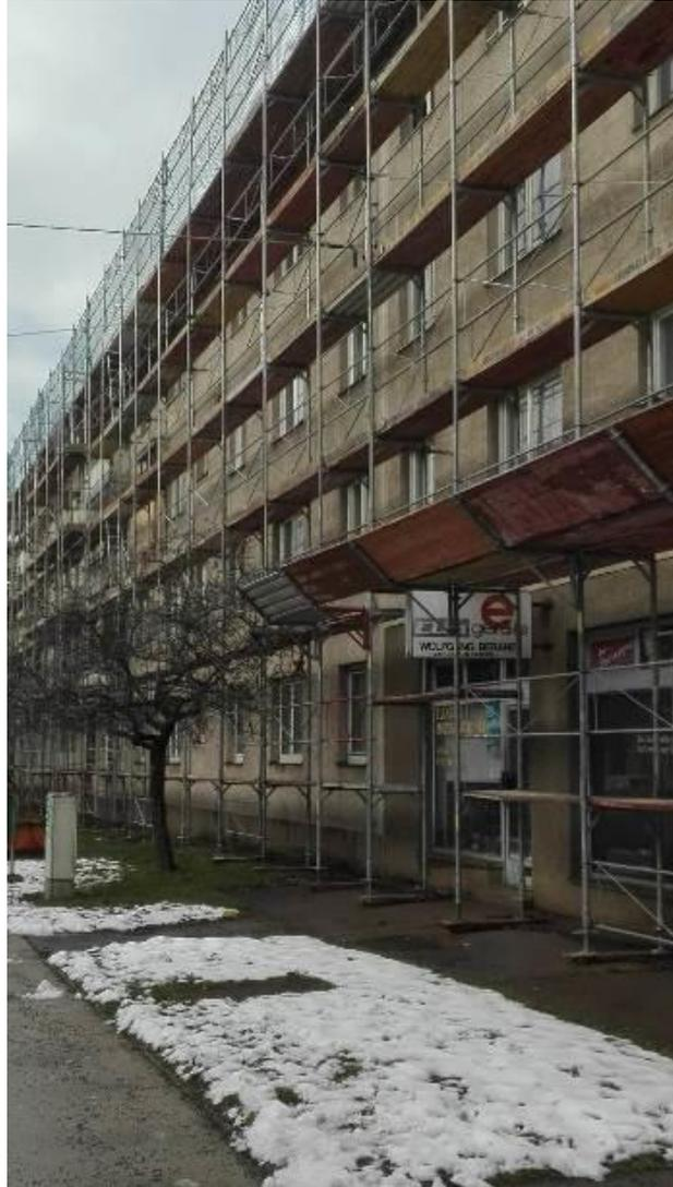
Abbildung 5: Hütteldorfer Straße 252 mit den Gerüsten der zukünftigen Multi-Aktiv Fassade (unten) und oben des Wärmeverbunddämmsystems
