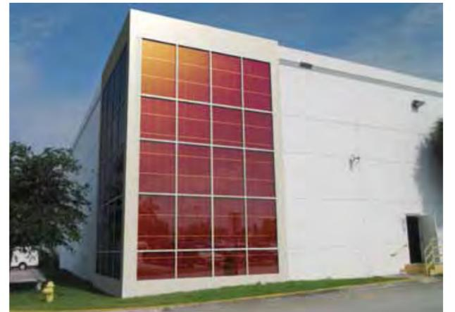
BIPV-Fassadenmodul Curtain Wall mit Konarka Power Plastic<sup>®</sup>. Foto: Konarka
