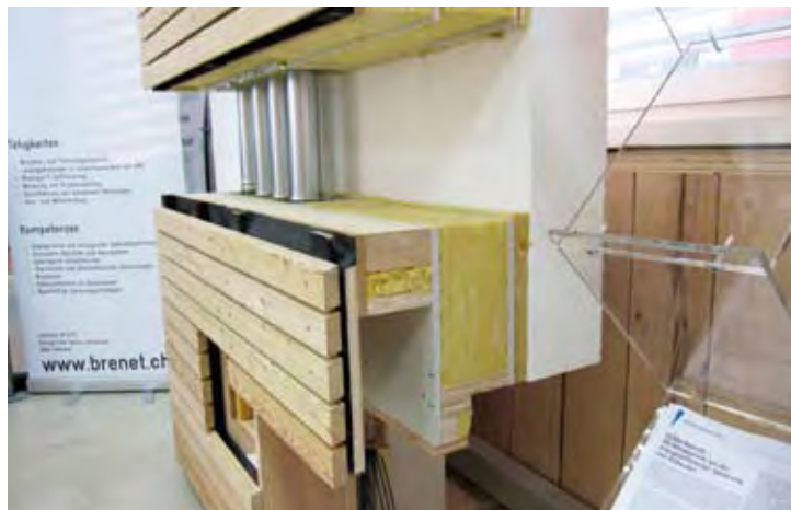
Prototyp Fassadenmodule: 1:1-Fassadenmodul mit integrierten Fenstern und integrierter Gebäudetechnik. Foto: FHNW, Inst. für Energie am Bau, René L. Kobler; Bächli Holzbau
