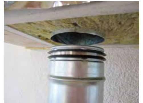
Verbindung der Lüftungsrohre – Zusammenstecken am Bau: Teleskop rausziehen, ausrichten, einstecken – und mit den anderen Rohren gleich verfahren. Fotos: FHNW
