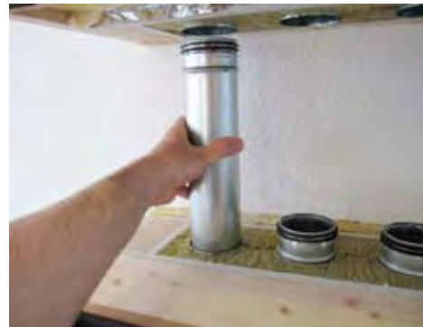
Verbindung der Lüftungsrohre – Zusammenstecken am Bau: Teleskop rausziehen, ausrichten, einstecken – und mit den anderen Rohren gleich verfahren. Fotos: FHNW
