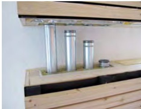
Verbindung der Lüftungsrohre – Zusammenstecken am Bau: Teleskop rausziehen, ausrichten, einstecken – und mit den anderen Rohren gleich verfahren. Fotos: FHNW
