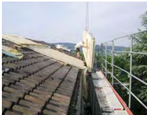
Mehrfamilienhaus Zürich Höngg: Bestandsgebäude, Herstellung und Montage der Sanierungsmodule und nach der Sanierung. Fotos: Kämpfen für Architektur, Beat Kämpfen
